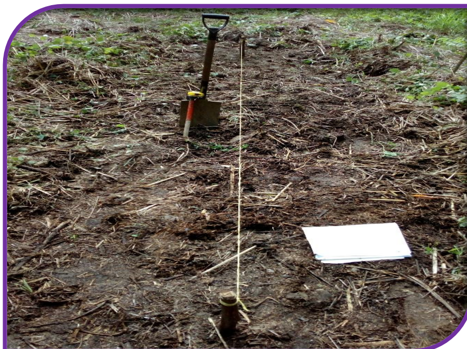
Fotografía 2: Trazado y marcación del terreno para la instalación
