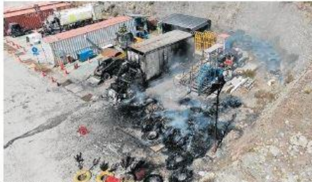
Las instalaciones de Chancas, en el lapso Chichas, propiedad de MMC, quedaron seriamente afectadas tras el ataque de comuneros de Huancuñire.
