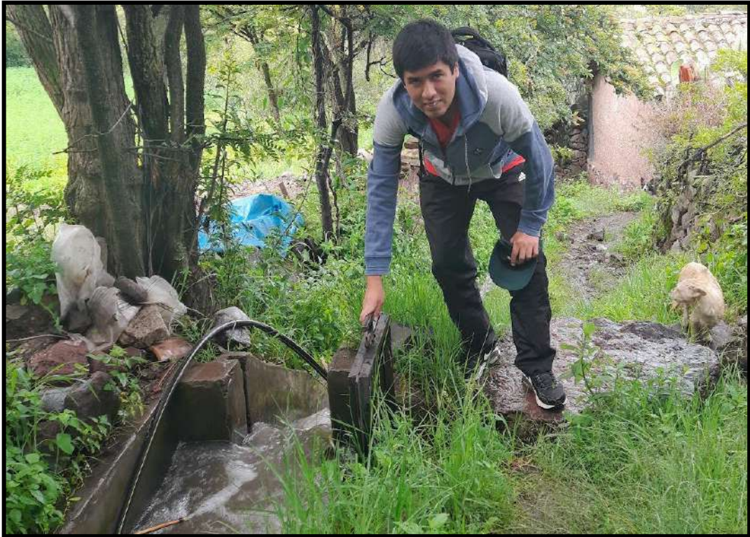
Foto 9. Verificación de la compuerta
