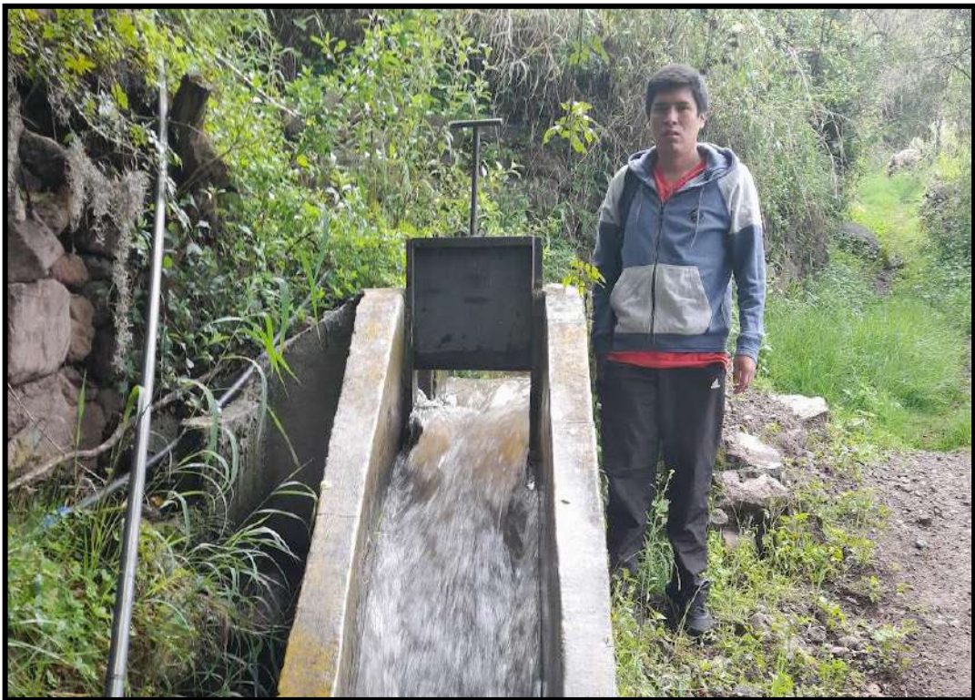
Foto 8. Verificación del funcionamiento de la compuerta del canal de riego
