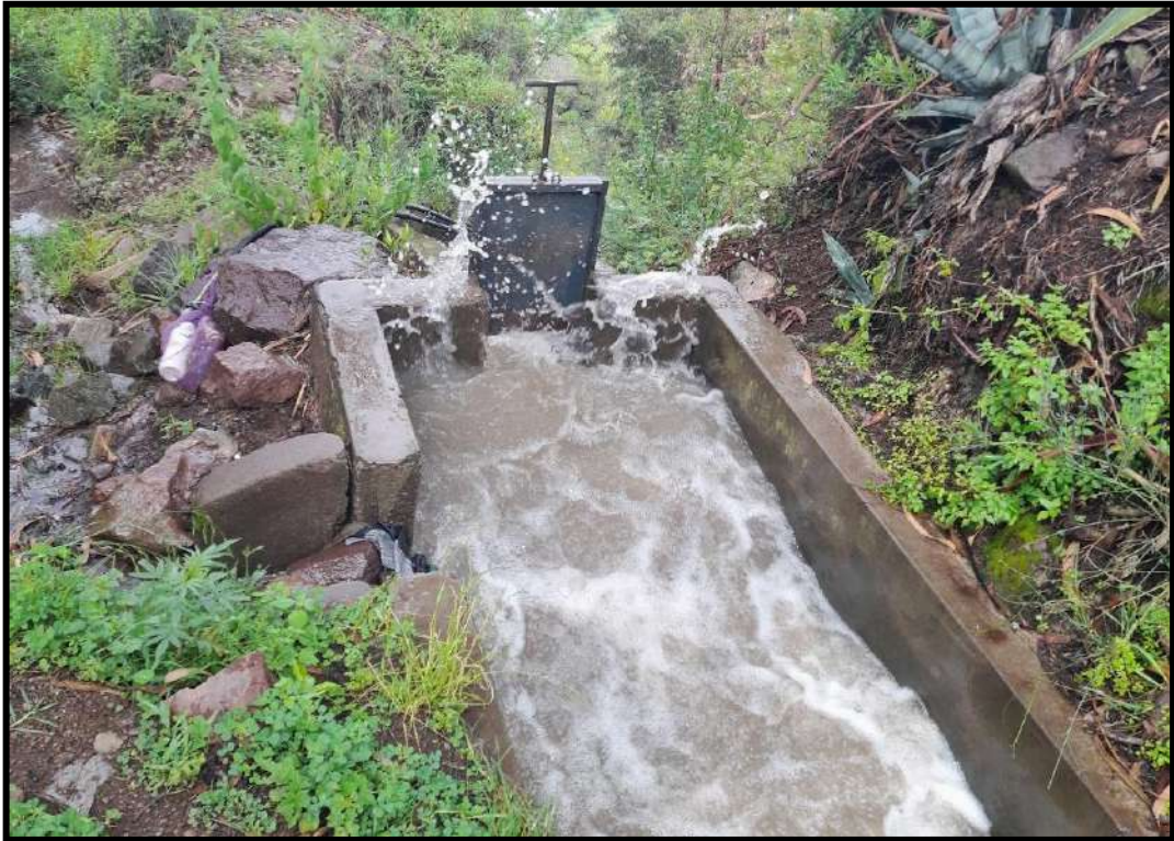
Foto 7. Observaciones del funcionamiento del dissipador de energía más demasías
