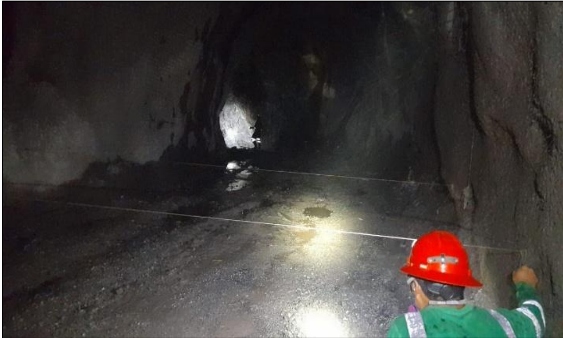
Figura 68 Sacando Punto centro y gradiente.
