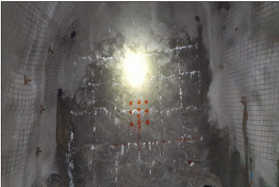
Figura 78 Pintado de Malla de perforación y arranque CX 4040
