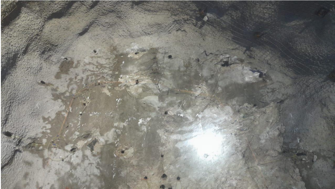
Figura 81 Perforación en frentes
