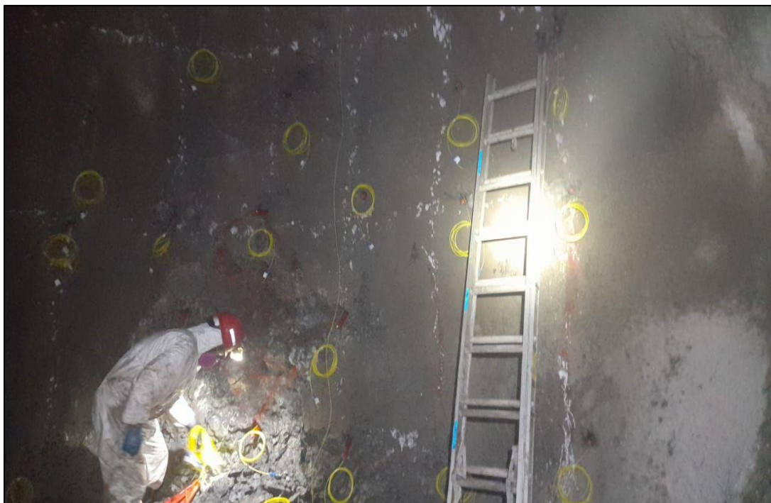
Figura 90 Distribución de faneles en frente
