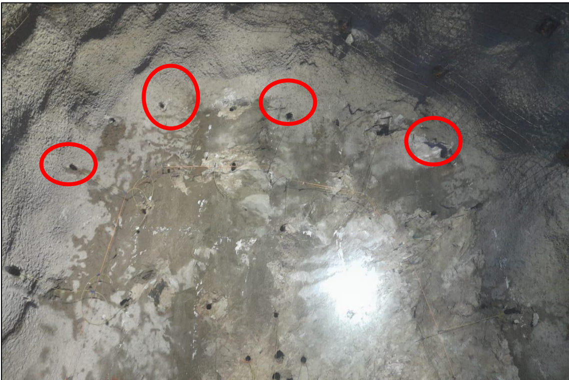
Figura 82 Perforación de taladros de alivio en la corona.
