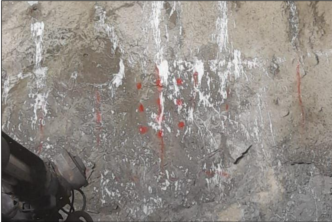
Figura 78 Pintado de Malla de perforación y arranque CX 4040
