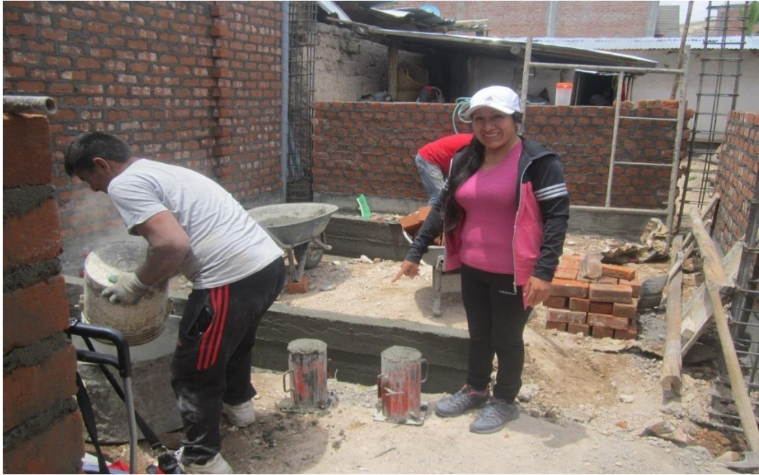
Fotografía 15: Toma de muestra de columna vivienda número 09, preparado de mezcla en cilindros, traslado con baldes.
