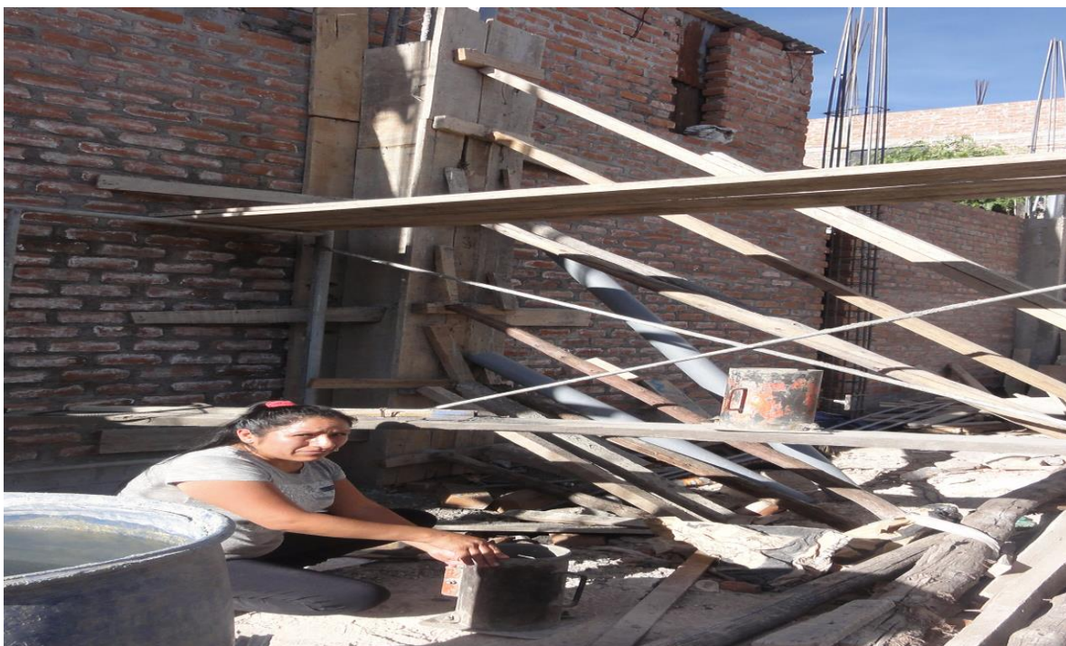
Fotografía 05: Toma de muestra de columna de vivienda numero 02
