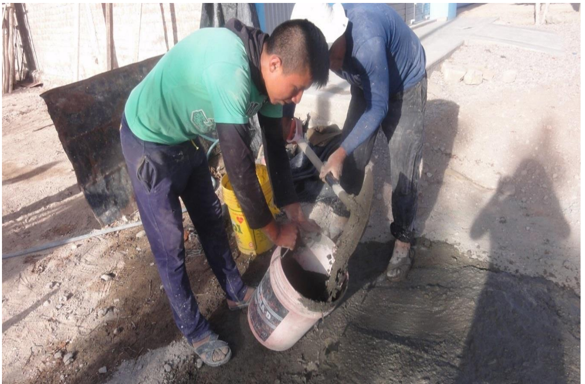
Fotografía 08: Preparado de mezcla en el suelo, Traslado en baldes vivienda numero 03
