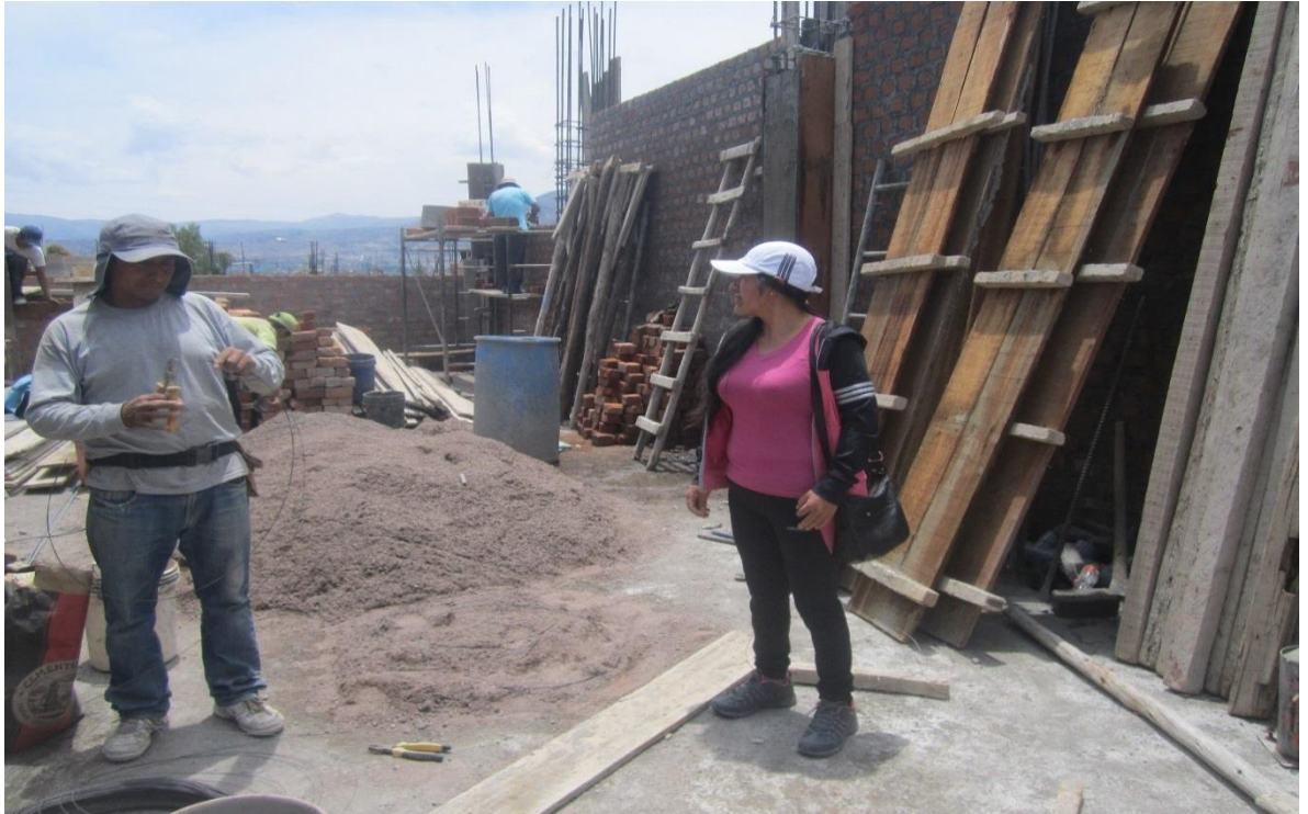
Fotografía 18: Entrevista al maestro responsable de la obra, de la vivienda numero 12
