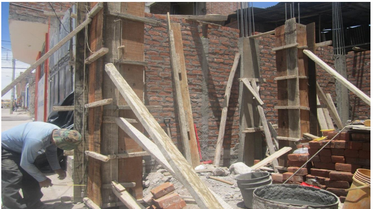
Fotografía 25: Columna de vivienda número 17, mezcla preparada en cilindro, traslado con baldes
