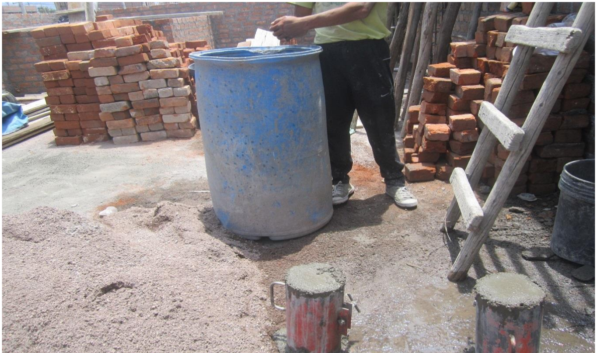
Fotografía 22: Lugar de almacenamiento de agregados, en contacto directo con limo y arcilla del suelo
