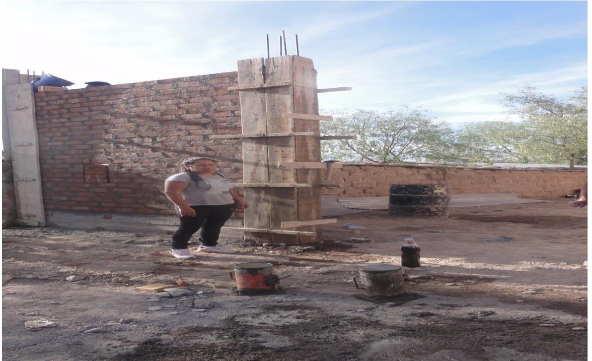
Fotografía 09: toma de muestra de columna de vivienda número 04, mezcla en el suelo, vaciado con baldes.
