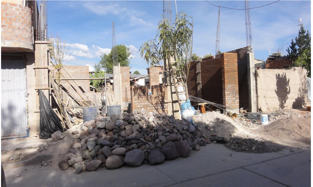
Fotografía 22: Lugar de almacenamiento de agregados, en contacto directo con limo y arcilla del suelo
