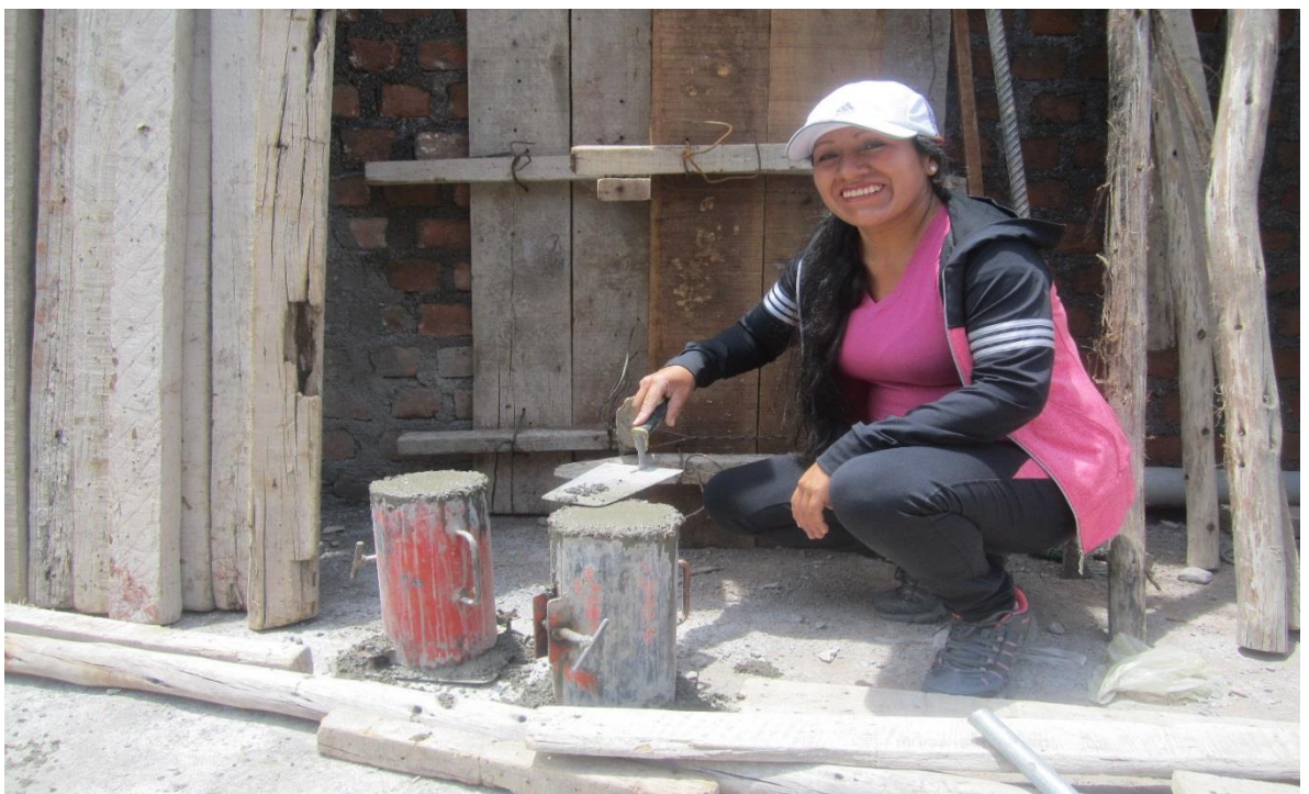
Fotografía 19: toma de muestra de columna de vivienda número 12, preparado de mezcla en piso de azotea, traslado en baldes.
