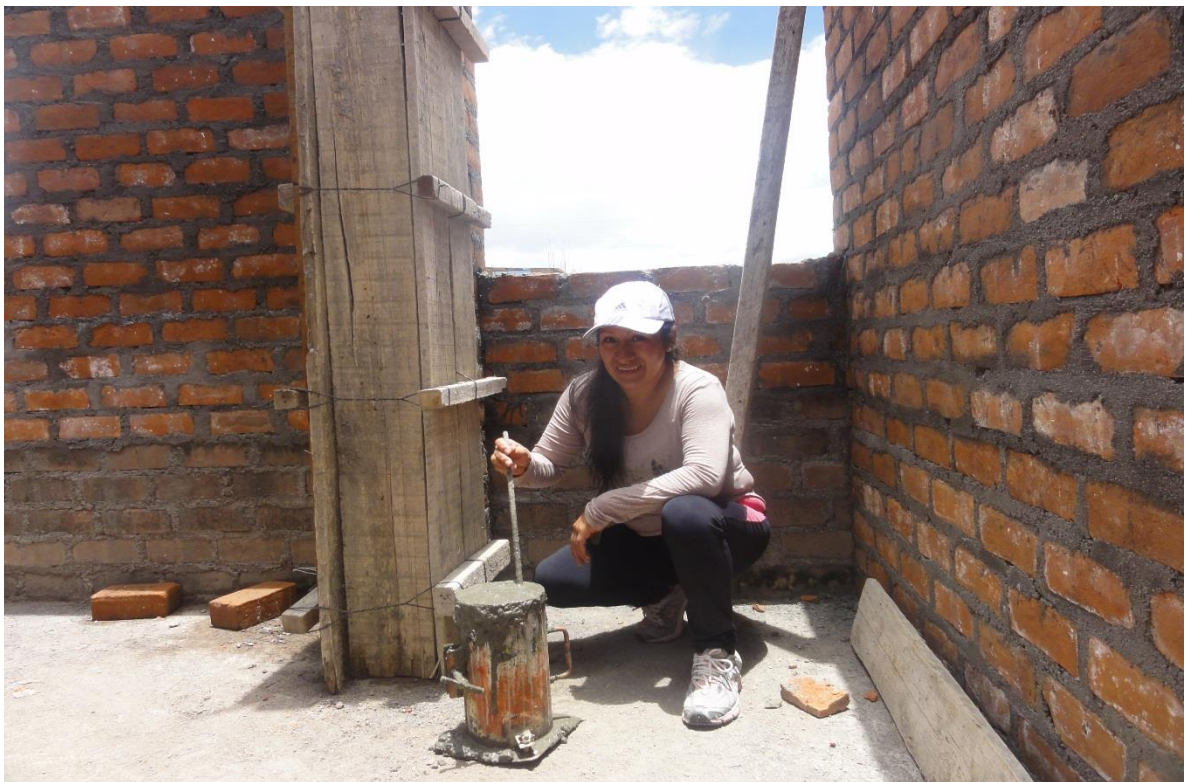
Fotografía 12: Toma de muestra columna de vivienda número 06, preparado de mezcla en el piso, traslado en baldes.
