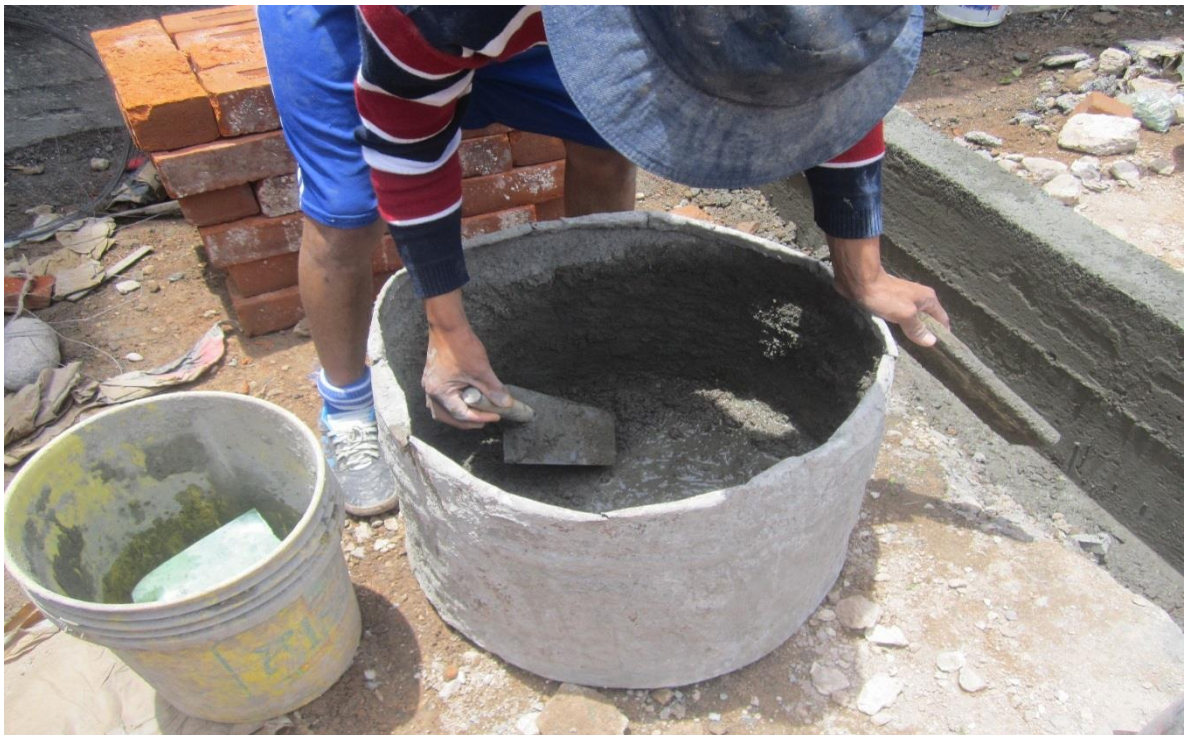
Fotografía 15: preparación de la mezcla vivienda número 09, en cilindros, traslado en baldes
