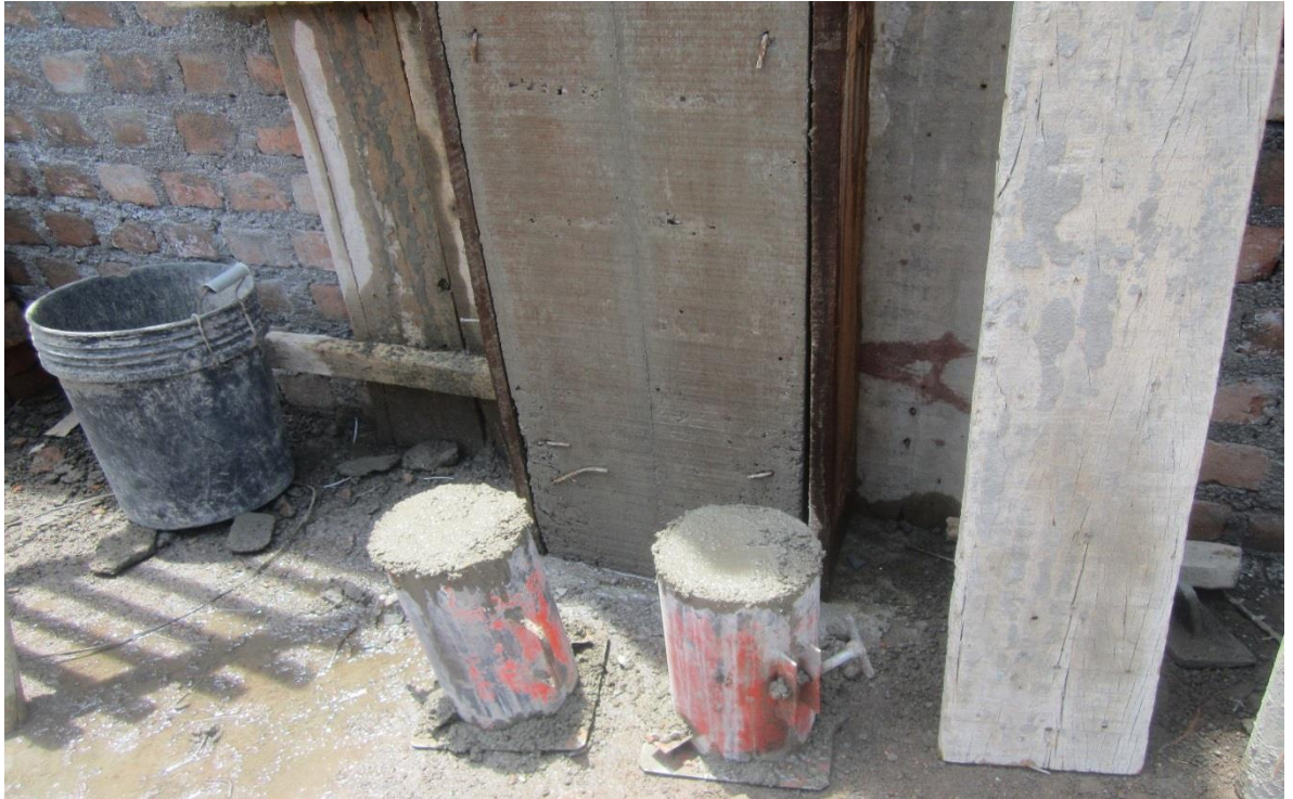
Fotografía 24: toma de muestra de columna vivienda numero 16
