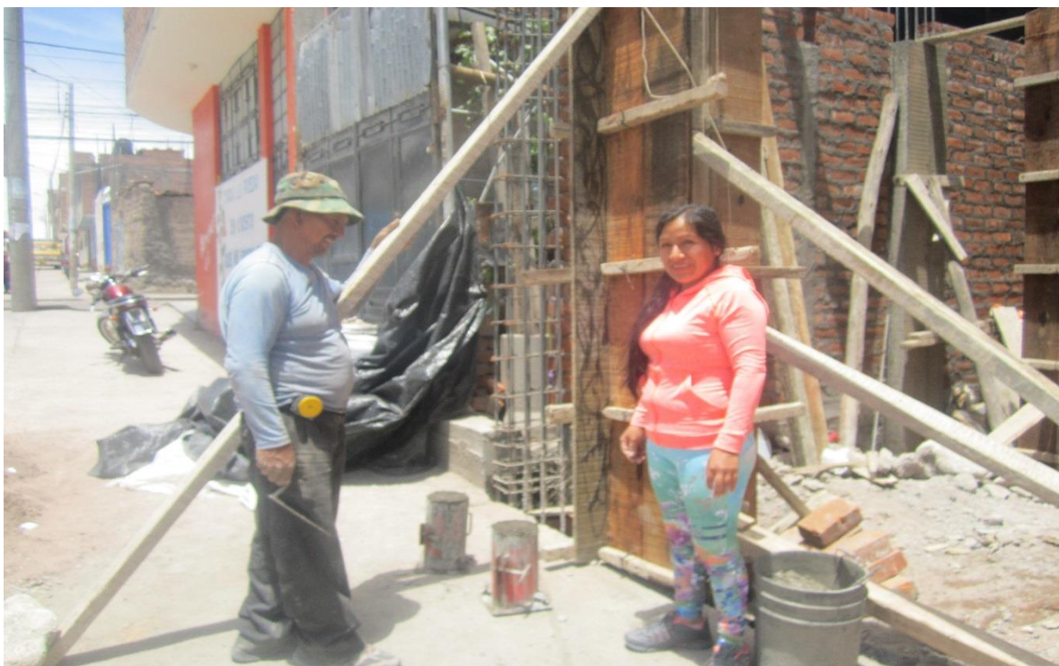
Fotografía 14: Toma de muestra columna de vivienda número 08, preparado de mezcla en el suelo, traslado con baldes.
