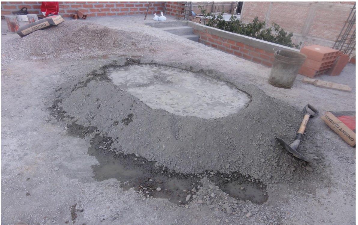
Fotografía 29: Preparado de mezcla en techo de la vivienda número 20, traslado con baldes.
