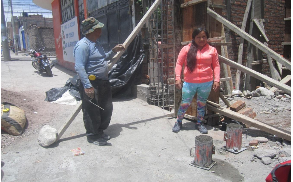
Fotografía 26: Toma de muestra de columna vivienda numero 17
