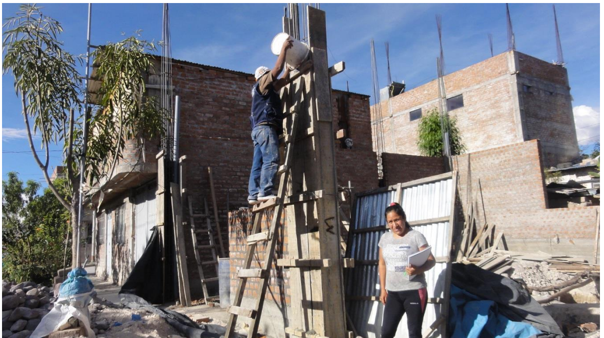
Fotografía 04: Vaciado de columna vivienda 01, transporte con baldes, preparación de la mezcla en cilindro
