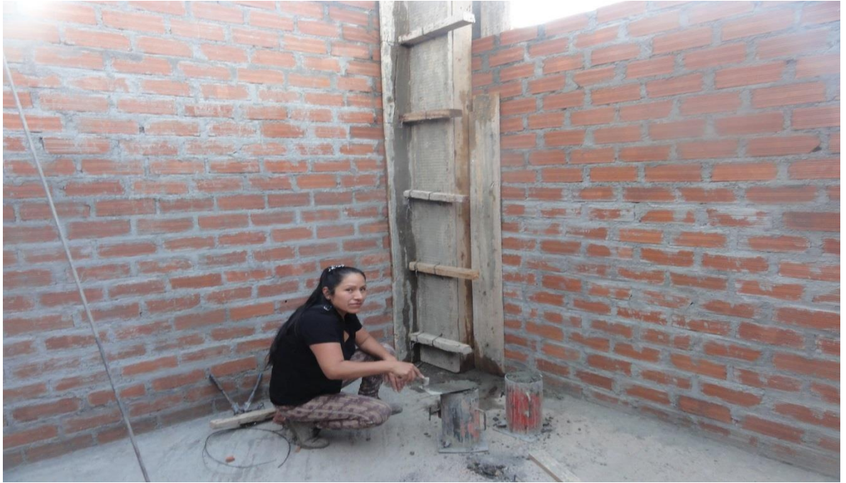
Fotografía 28: toma de muestra de columna de vivienda número 19, preparado de mezcla en cilindro, vaciado con baldes.
