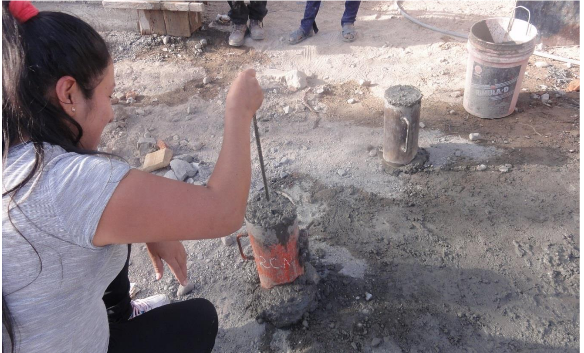
Fotografía 07: Toma de muestra de columna de vivienda numero 03
