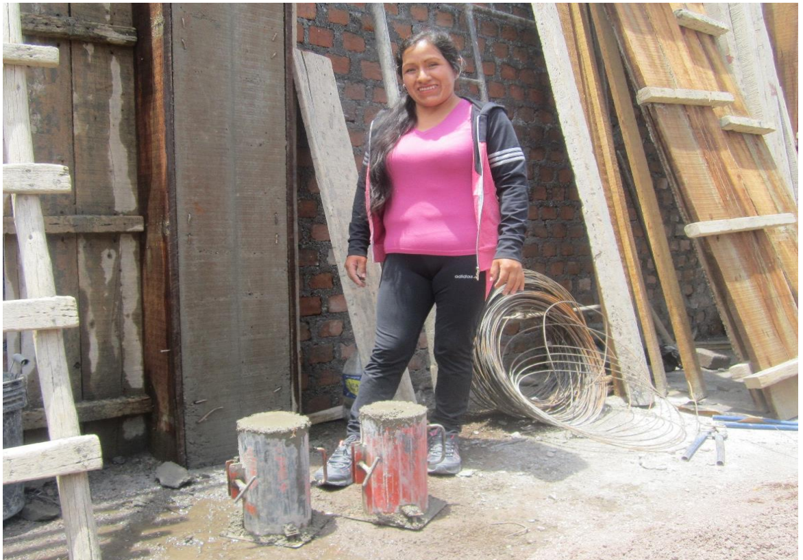
Fotografía 21: Toma de muestra de columna vivienda numero 14
