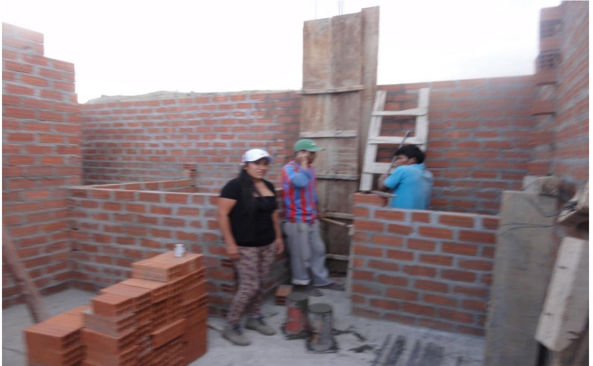
Fotografía 30: Toma de muestra de columna vivienda numero 20
