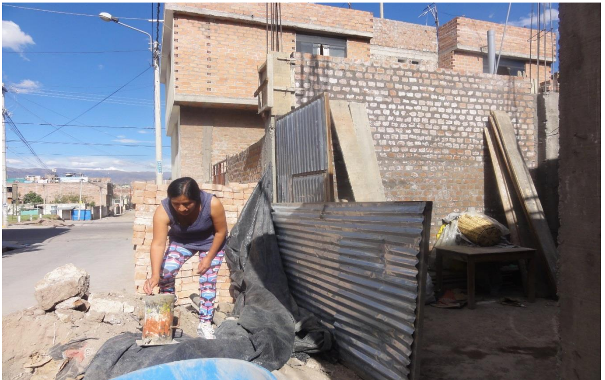
Fotografía 10: Toma de muestra de columna de vivienda número 05, preparación en el suelo, traslado en baldes.
