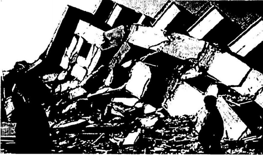
Figura 3-7: Falla por escasez de anclaje del refuerzo de la columna en su conexión con el sistema de piso
