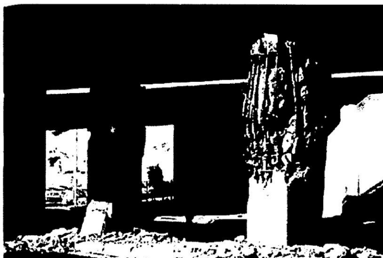
Figura 3-6: Falla de columnas con escaso refuerzo transversal.
