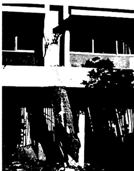
Figura 3-9: Falla de columna por efecto de cortante y torsión producida por excentricidad de la viga longitudinal.
