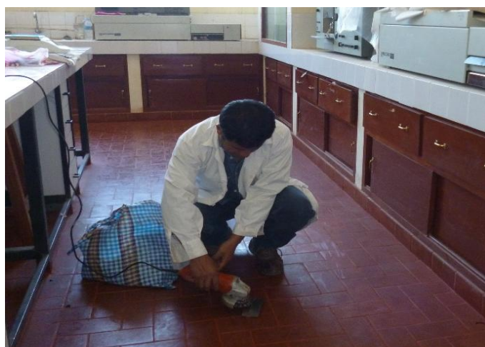
Figura 4.16. Limpieza mecánica, norma SSPC-SP-3
