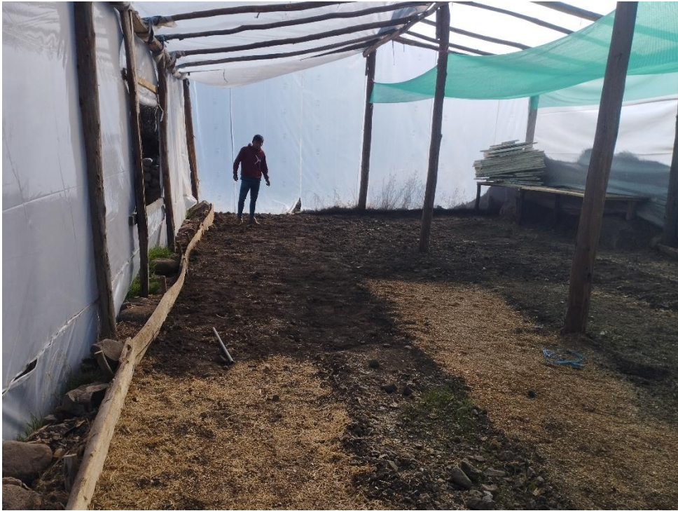
Ilustración 2. Nivelación del terreno a instalar
