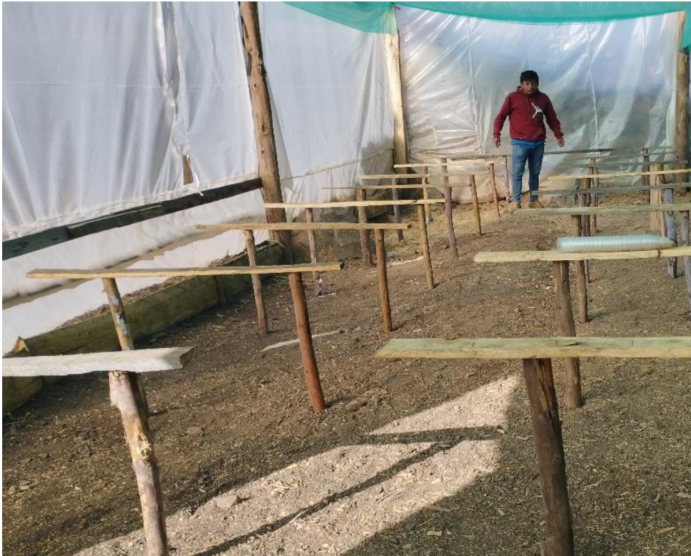
Ilustración 3. Instalación de la base de soporte para el sistema NFT
