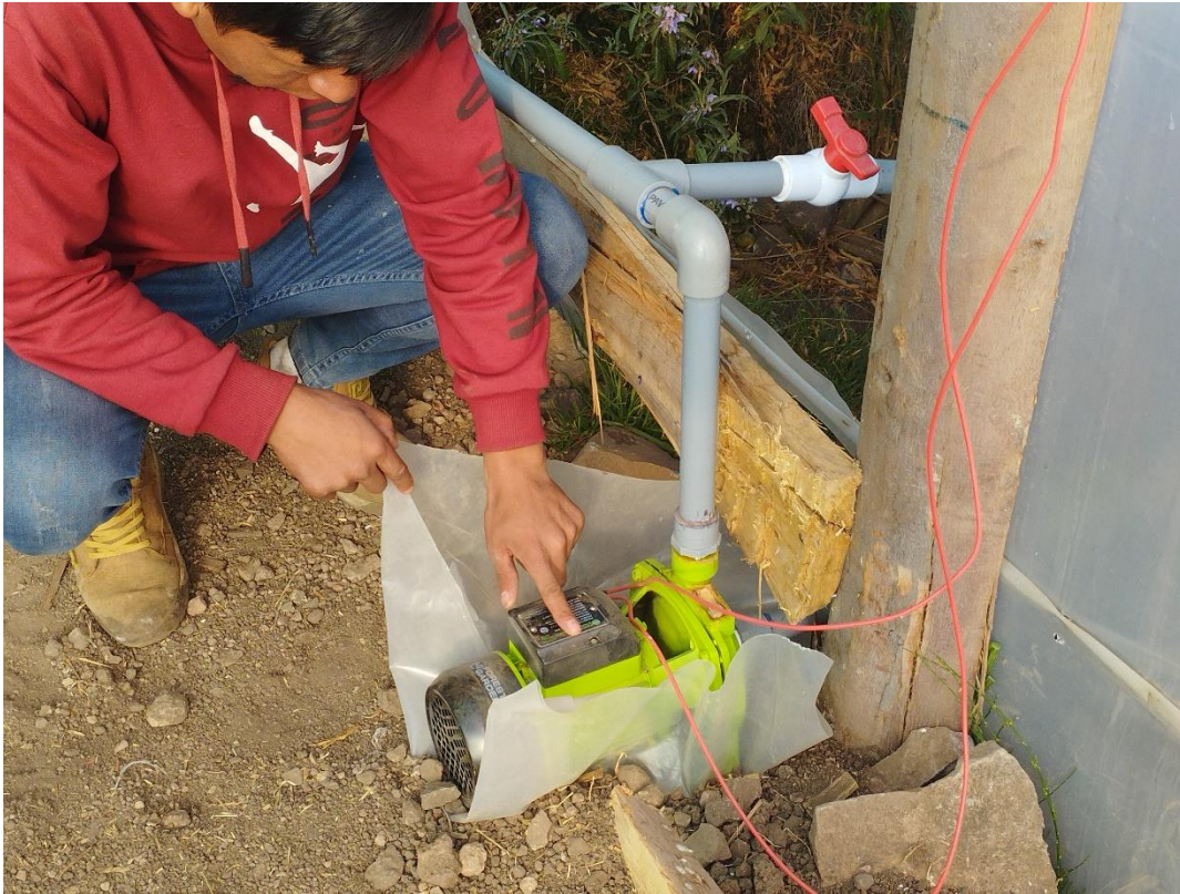
Ilustración 6. Instalación de la bomba de impulsión.
