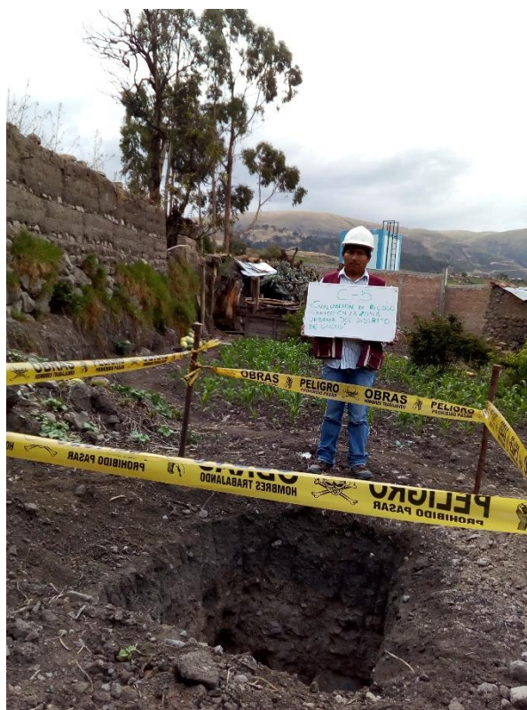
Figura 7. Calicata C-05, ubicada entre en el Jr. Progreso - Jr. San Cristóbal
