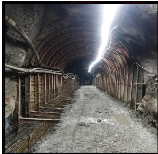
Ilustración 2: Sostenimiento con cimbras metálicas
