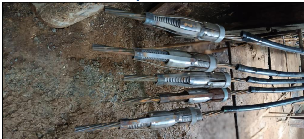
Ilustración 33: Instalación Cable Bolting
