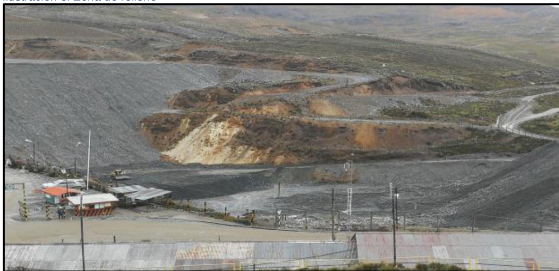
Ilustración 3: Zona de relleno
