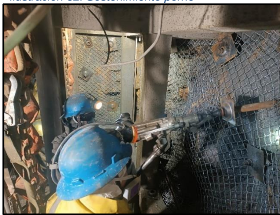
Ilustración 32: Sostenimiento perno
