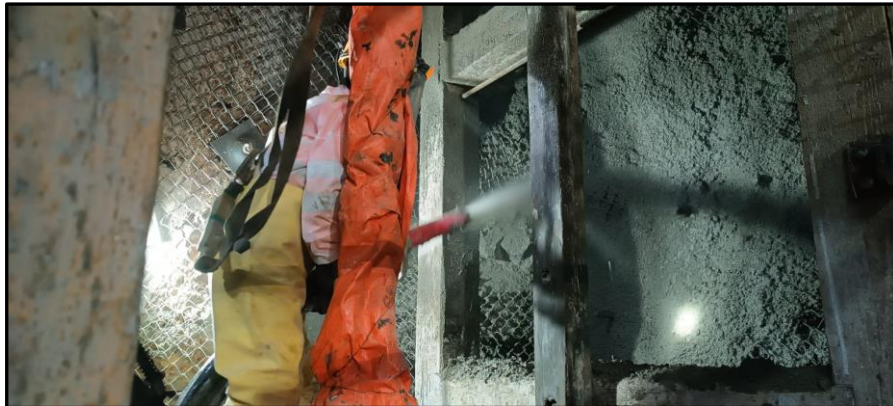
Ilustración 34: Lanzado Shotcrete
