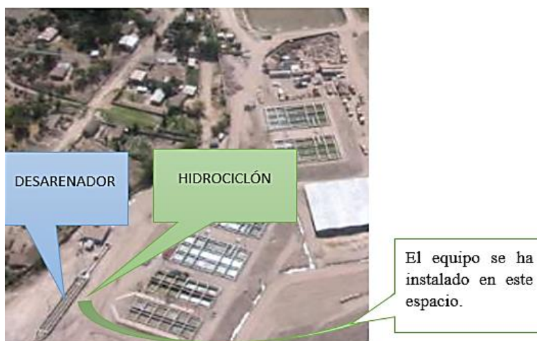
Figura 16. Ubicación de la instalación del equipo de hidrociclón
