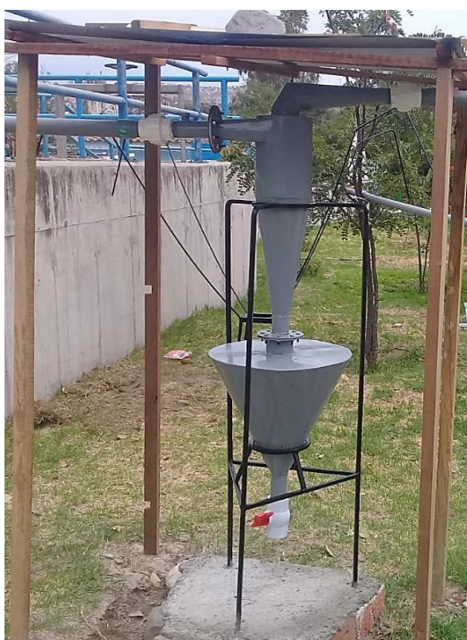
Figura 43. Instalación del hidrociclón
