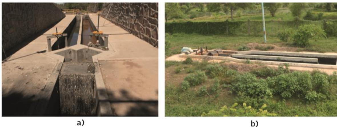
Figura 3. Desarenadores horizontales (Ruiz,2010).
