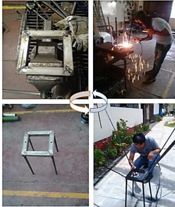
Figura 31. Construcción del módulo para el soporte de la electrobomba
