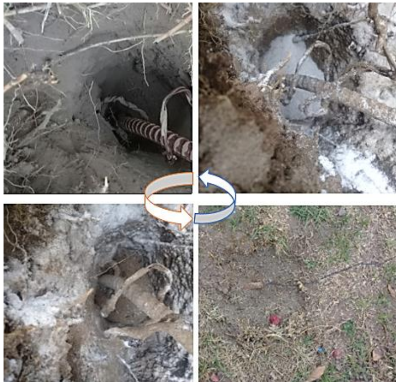
Figura 44. Construcción del pozo a tierra
