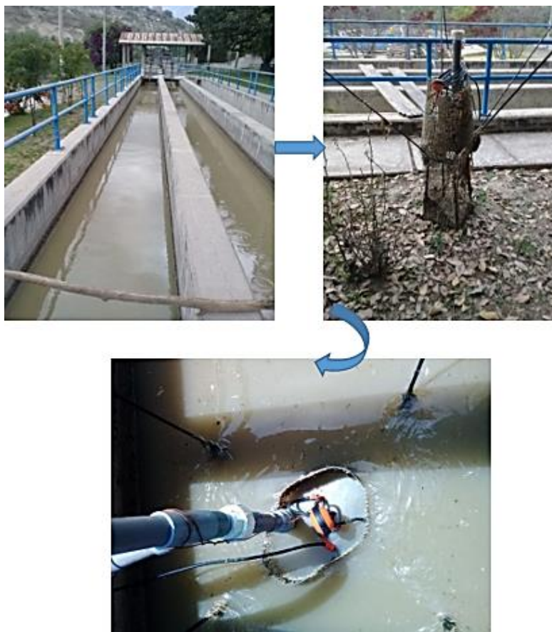
Figura 41. Instalación del sistema de captación
