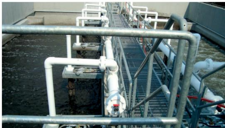
Figura 5. Desarenador aireado (Ruiz, 2010).
