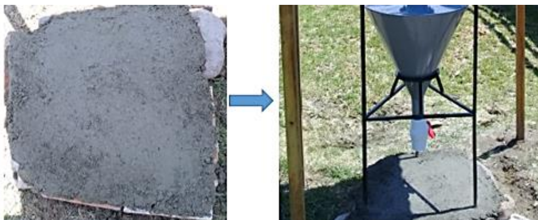
Figura 42. Instalación del modulo
