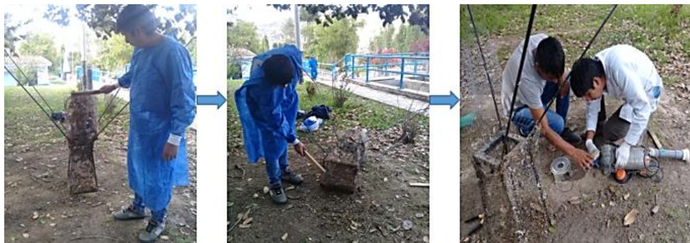
Figura 53. Mantenimiento de la estructura de la electrobomba sumergible
