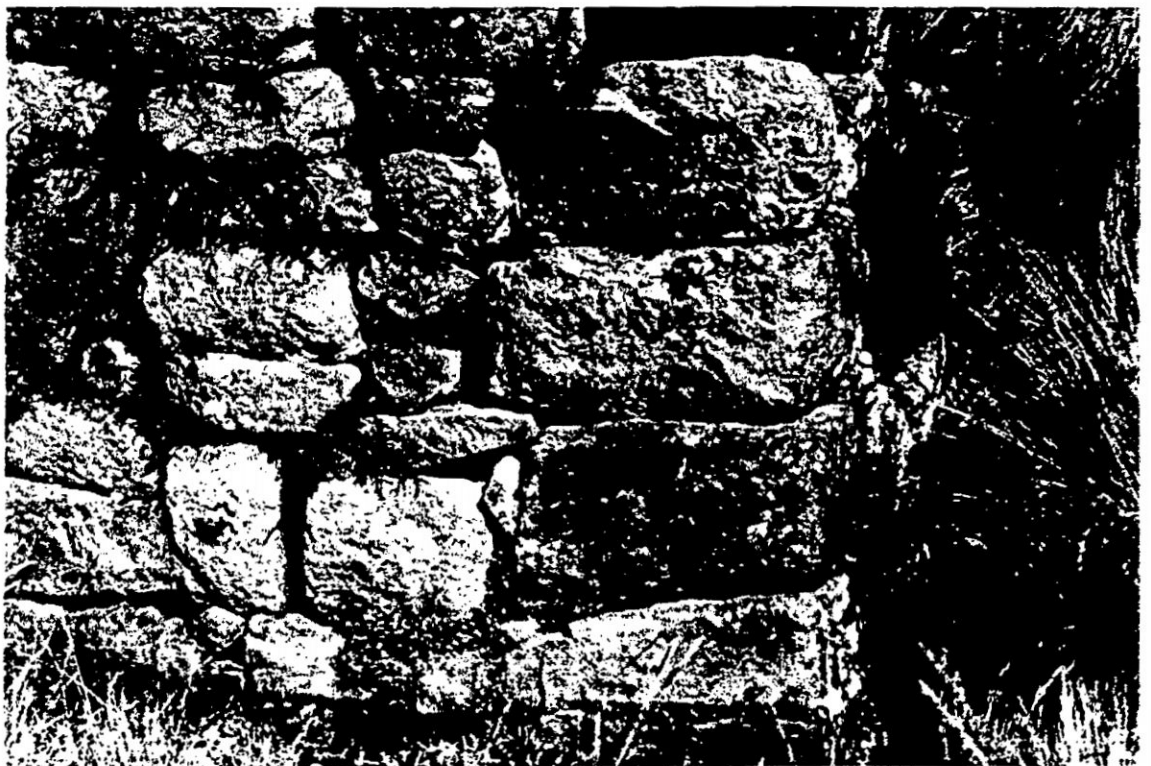
Foto N° 18: Detalle del paramento del muro, Cancha N° 1
