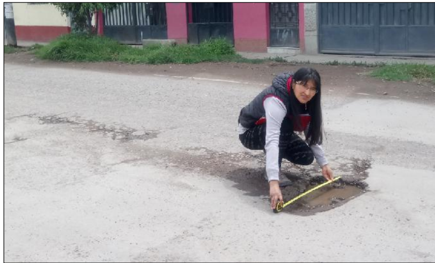
Medida del área de baches después del “parchado” en la Av. Javier Pérez de Cuellar
