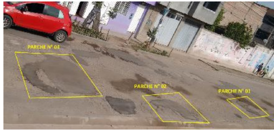
Identificación de parchado de baches en la Av. Javier Pérez de Cuellar, cuadra 6
