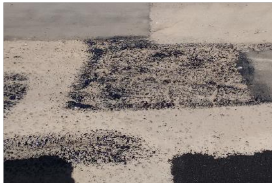
Se observa que la cantidad de ligante no llega a lo sugerido en la cita (7). Fuente: Elaboración propia
