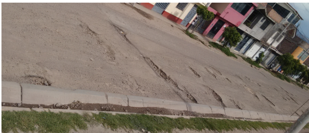
Figura 3.7: Condición del pavimento antes del bacheo de la Av. Javier Pérez de Cuellar
