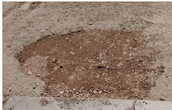
Reemplazo de base en un bache profundo Fuente: Elaboración propia
