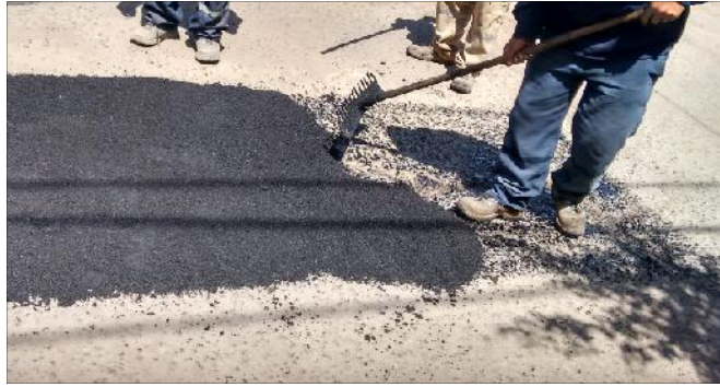
Expansión del material bituminoso sobre la superficie Fuente: Elaboración propia
