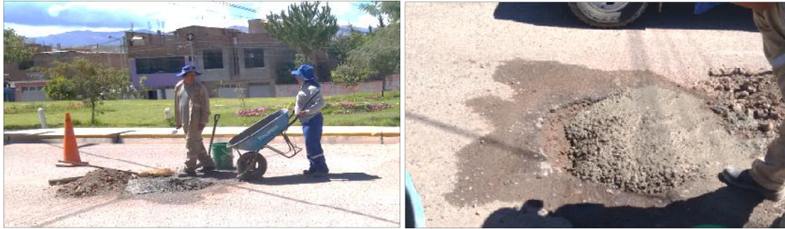
Relleno de bache con concreto hidráulico en Pavimento Asfáltico de la Av. Javier Pérez de Cuellar.
