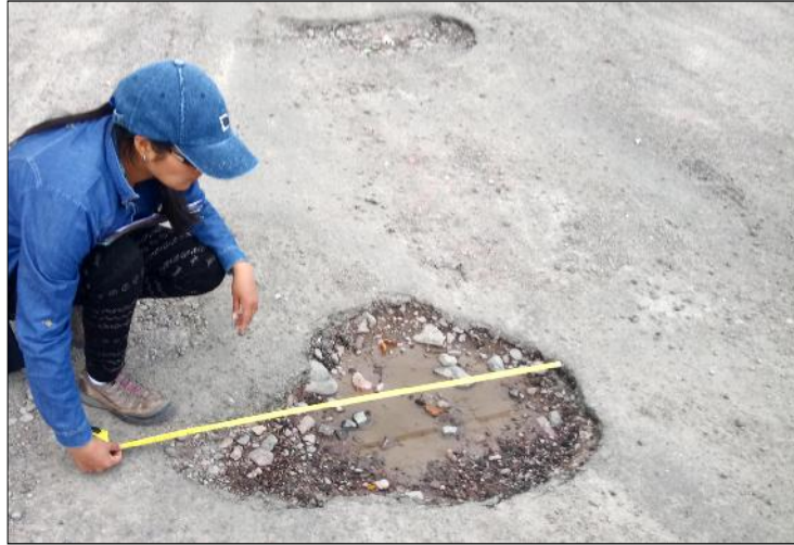
Medida del área de bache en la Av. Javier Pérez de Cuellar antes del “bacheo”
