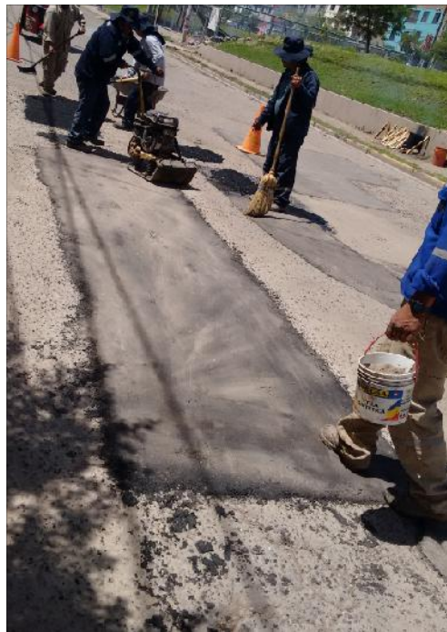
Uso de compactador manual para la capa superficial
