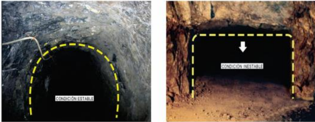
Figura 4. Formas de las excavaciones.
