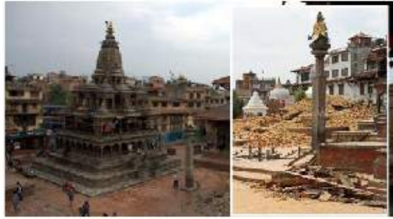
Fig. 3 Antes y después del terremoto de Nepal – Asia.
