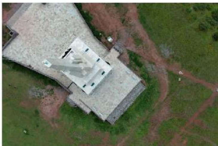
Imagen 1. Vista de la toma de fotogrametría con ortofotos de DRONE.
