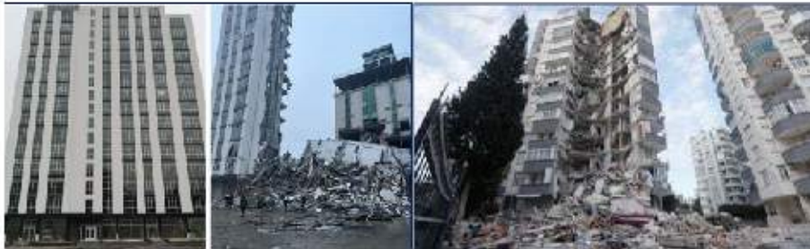
Fig. 4 Edificios de concreto armado devastados por el terremoto en Turquía.
