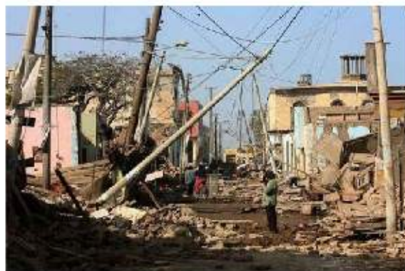
Fig. 11 Daño ocasionado por el terremoto de Ica, Perú 2007.
