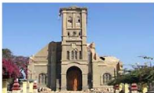
Fig. 10 Después del terremoto en Ica - Perú 2007.
