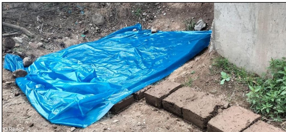
Figura 46. Protección de los adobes con plástico
