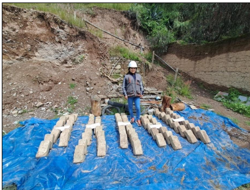
Figura 48. Almacenamiento de los adobes para su secado
