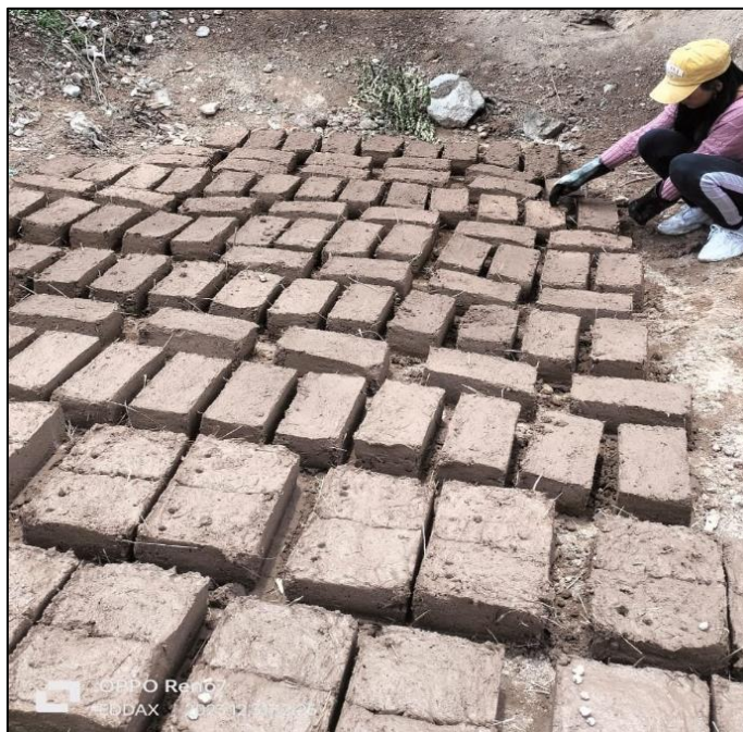
Figura 45. Elaboración de adobes
