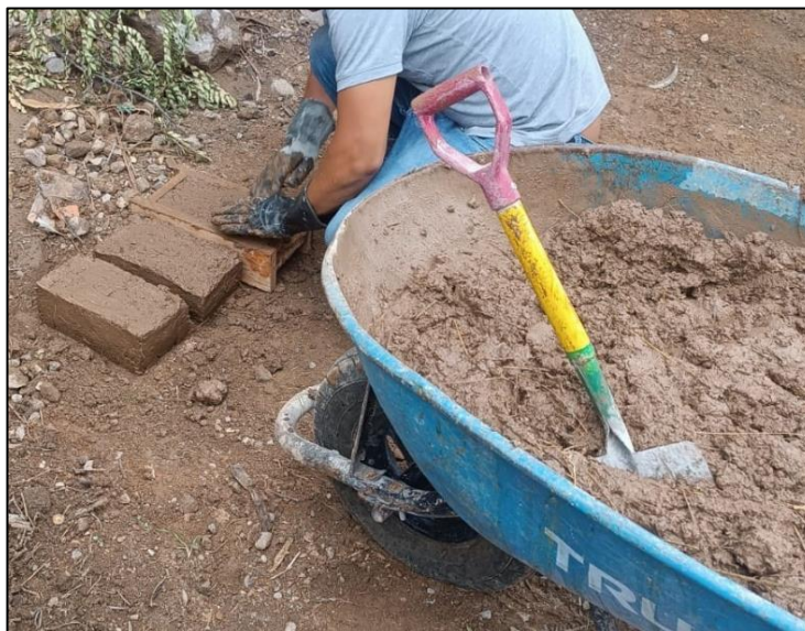
Figura 44. Elaboración de adobes
