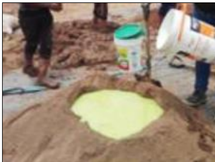
Figura 43. Mezcla con mucílago de nopal
