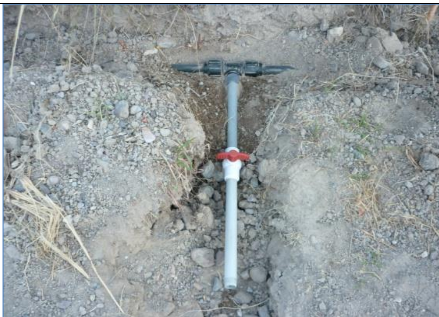
Instalación de accesorios de riego
