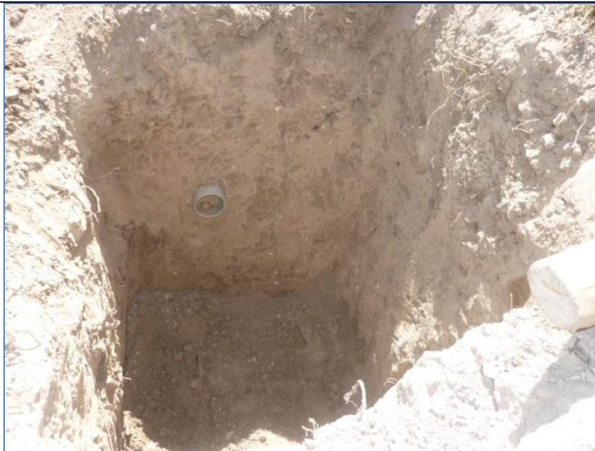
Calicata para determinación de coeficientes hídricos
