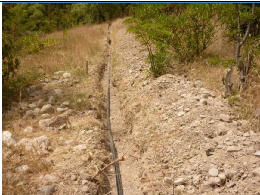
Instalación de riego
