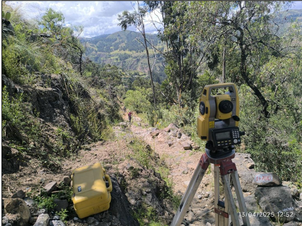
Imagen 17: Levantamiento topográfico para la viabilidad de una alternativa de inversión pública – Tramo II (Accechuay a Reservorio)
