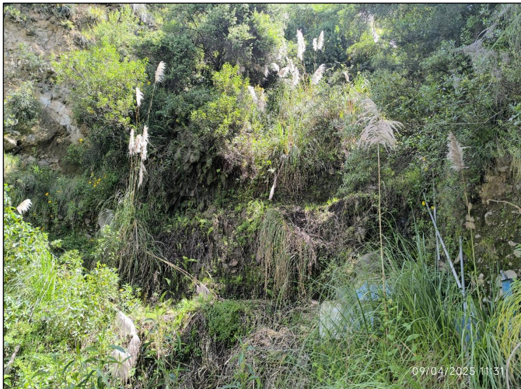
Imagen 10: Nueva captación Accechuay; para el proyecto de inversión pública de tipo lateral
