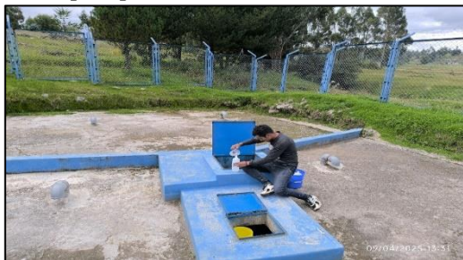
Punto de muestreo bocatoma Tornopampa (M-01)
