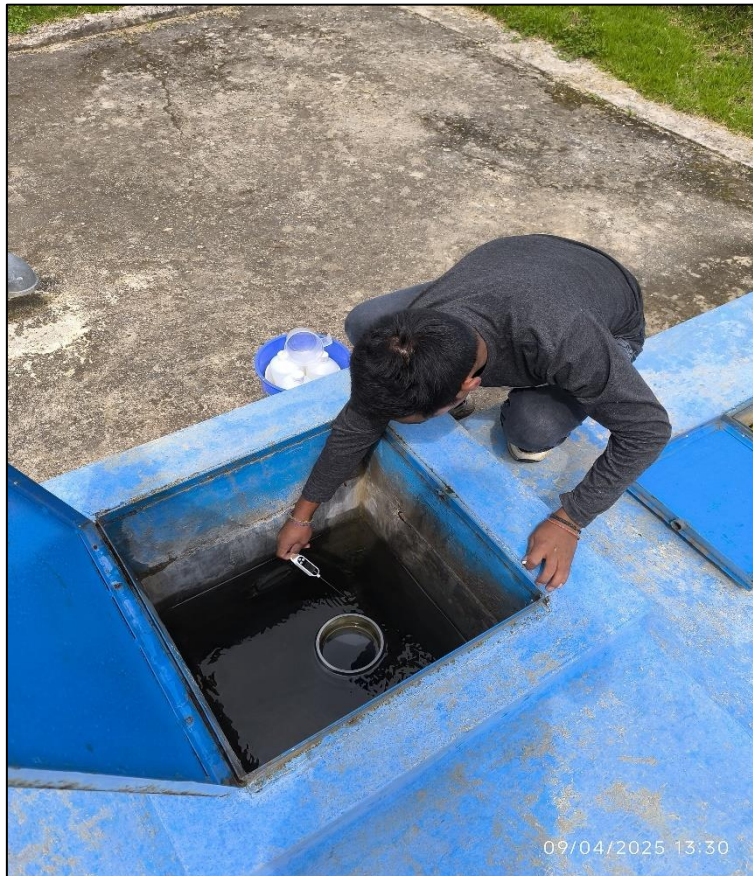
Imagen 4: Medición de temperatura en la Captación Tornopampa
