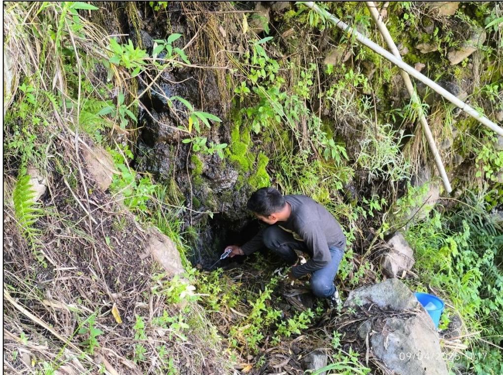
Imagen 7: Medición de temperatura en la Captación Accechuay
