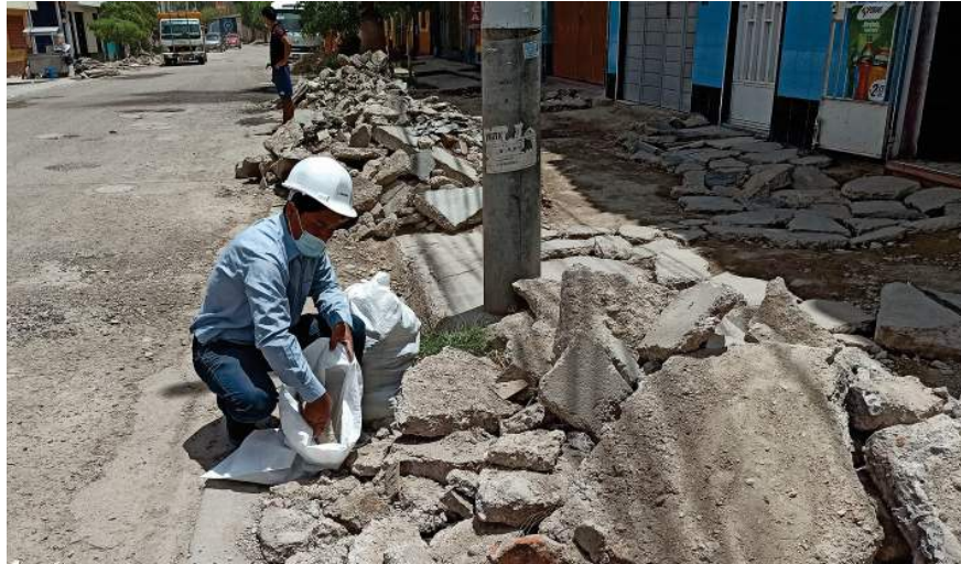
Figura 15 Vista fotográfica de las veredas demolidas. Fuente: Elaboración propia
