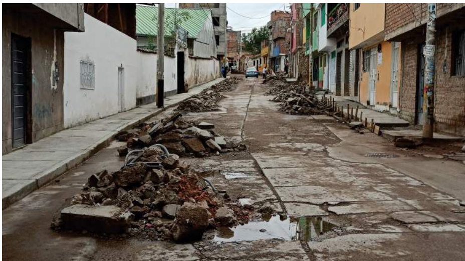
Figura 1 Residuos de la construcción y demolición de pavimento - 1 y 2 cdra del Jr la Mar, San Juan Bautista .
