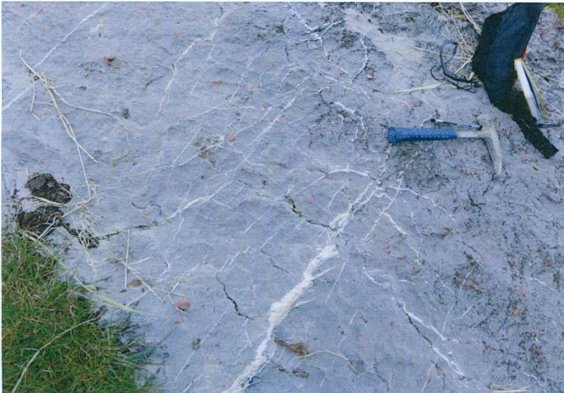
Fotografía N° 30 Vista de cerca macizo rocoso de caliza in-situ
