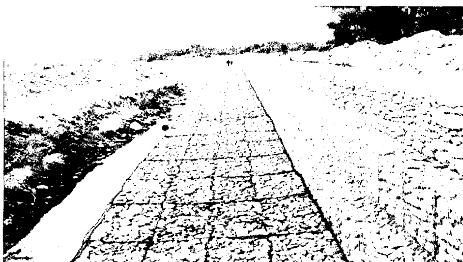
FOTOGRAFÍA N° 25, GAVIONES HECHAS CON ROCA CALIZA, www.canterasleonesas.com
