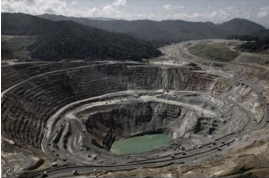
Figura 2. Talud de excavación minera
