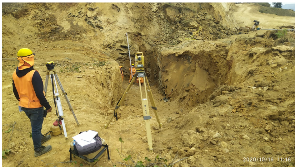
Figura A.14: Control Topográfico en estructuras puntuales.
