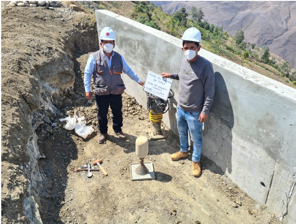
Figura A.17: Verificación de la construcción de obras de arte.
