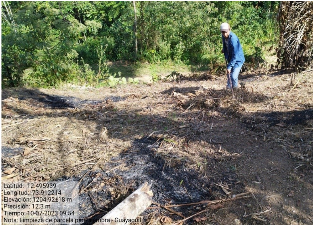
Foto 01. Limpieza y acondicionamiento de terreno Sivia – C.P Guayaquil 1243 msnm.
