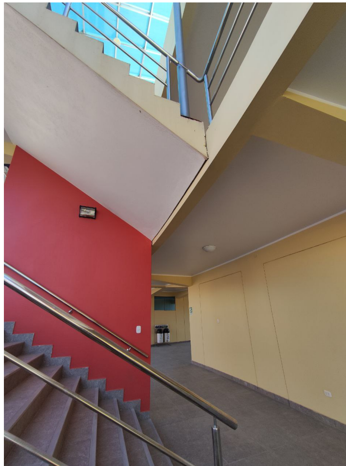
Figura B.16 Junta sísmica que separa la escalera del modulo 01
