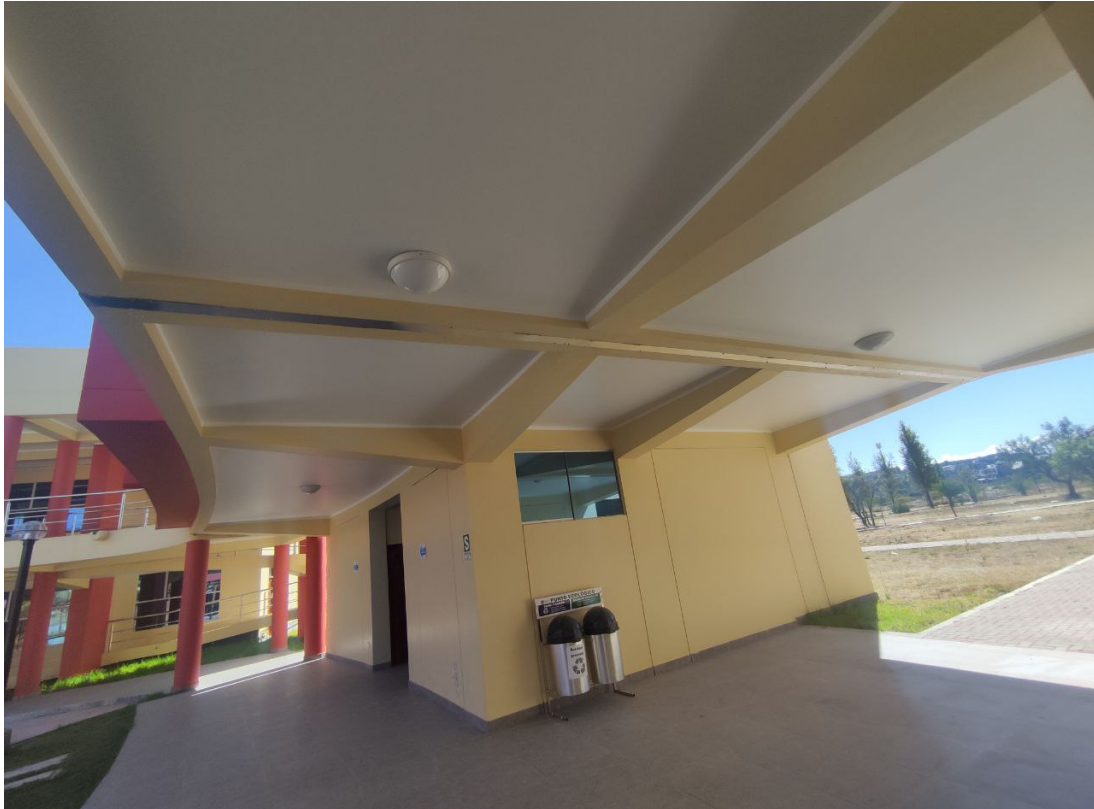
Figura B.17 Junta sísmica que separa el modulo 01-B del modulo 01-C
