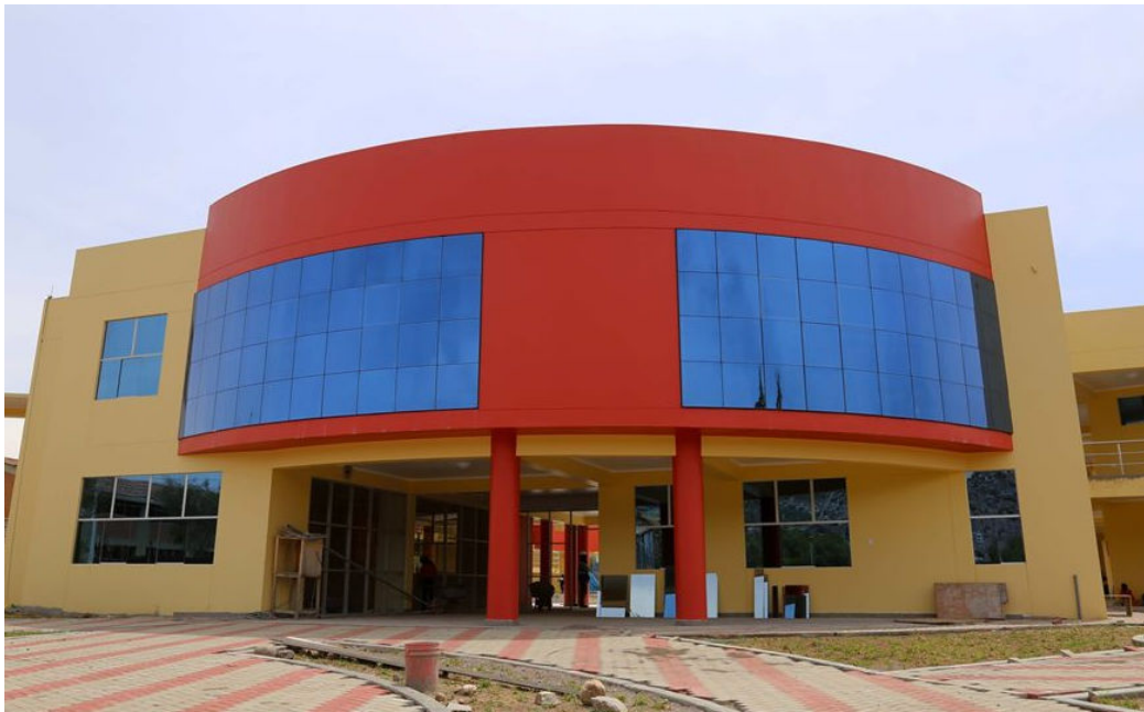
Figura B.13 Fachada de la infraestructura de Ingeniería de Minas
