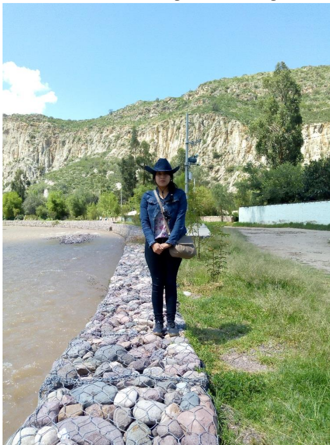
Foto 10. Defensa de márgenes del río - gaviones
