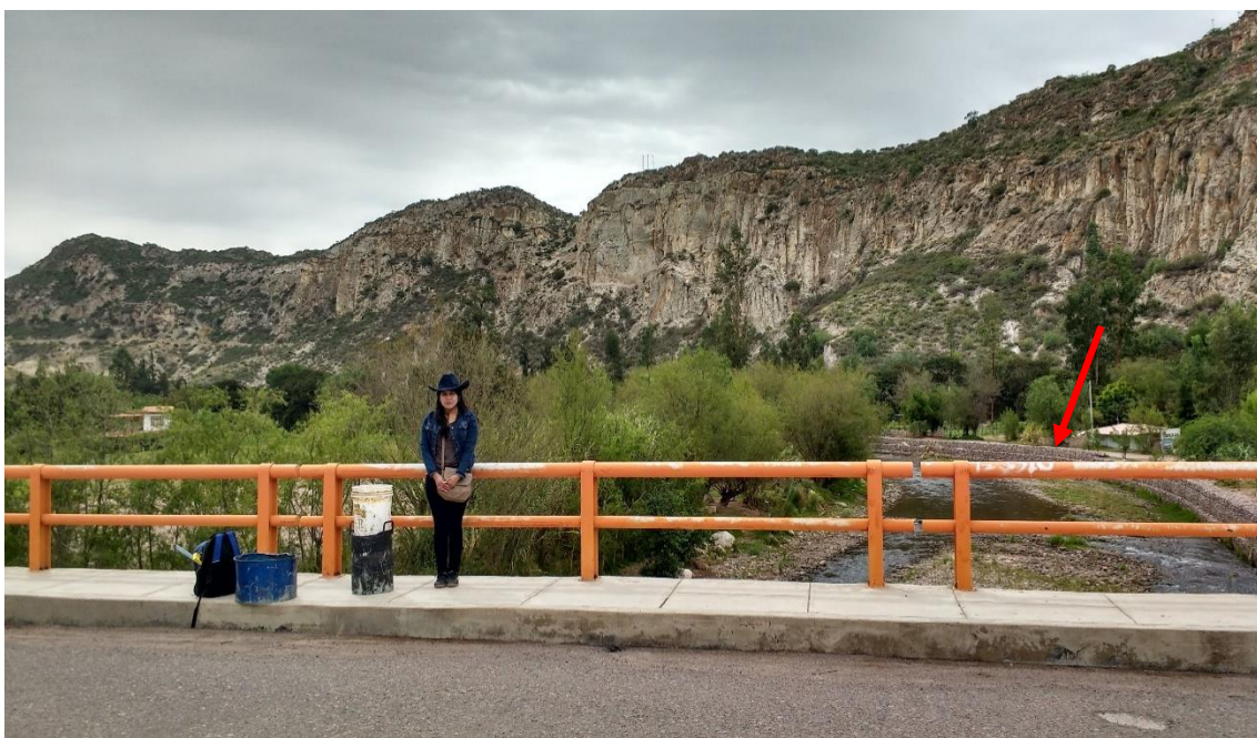
Foto 9. Prácticas de conservación en las márgenes del río (gaviones)
