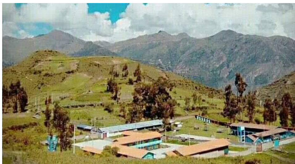
Foto N° 04 Centro educativo la I. E. MX/P N. ° 38127. Fuente: Registro fotográfico personal, (20/10/2020)
