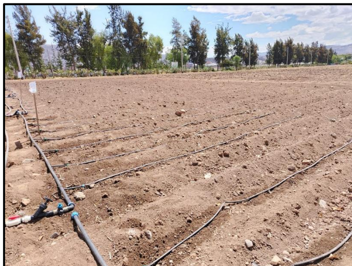
Fotografía 07. Instalación total del sistema de riego
