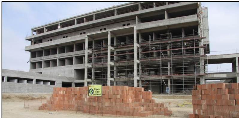
Fotografía 2: Hospital III en construcción - Ayacucho
