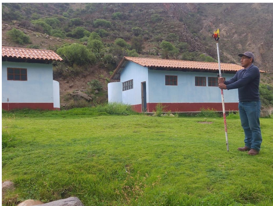
Foto 20: Infraestructura que sería afectado por una crecida de un evento.
