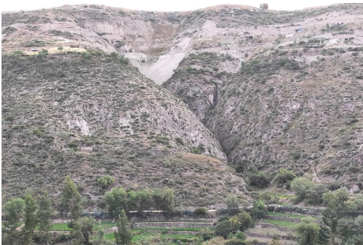
Fotografía N°5: Vista de Cárcavas producto de la erosión de suelos– zona de Muyurina
