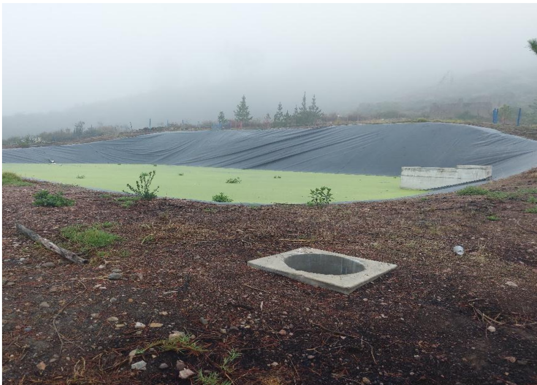
Anexo 7. Laguna de oxidación de la planta de tratamiento de aguas residuales del distrito Huayacundo.
