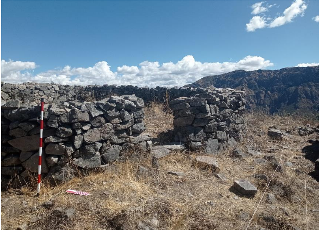
Figura 33. Exterior del Espacio arquitectónico N°1 (EA-01), Fuente: PIA Tinyacc.
