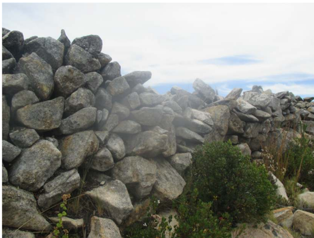
Figura 97. Detalle del paramento muro que delimita el sector B, tomado desde el este.
