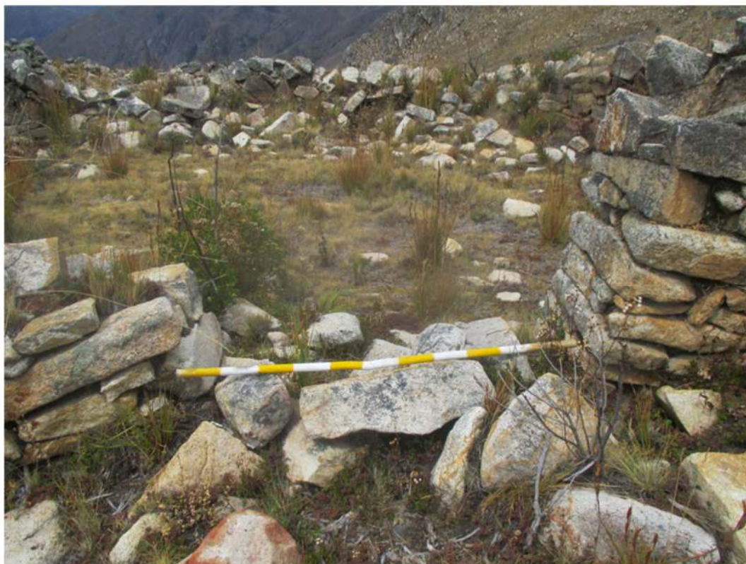
Figura 188. Detalle de un acceso a una estructura habitacional (EHS-197) sector B.
