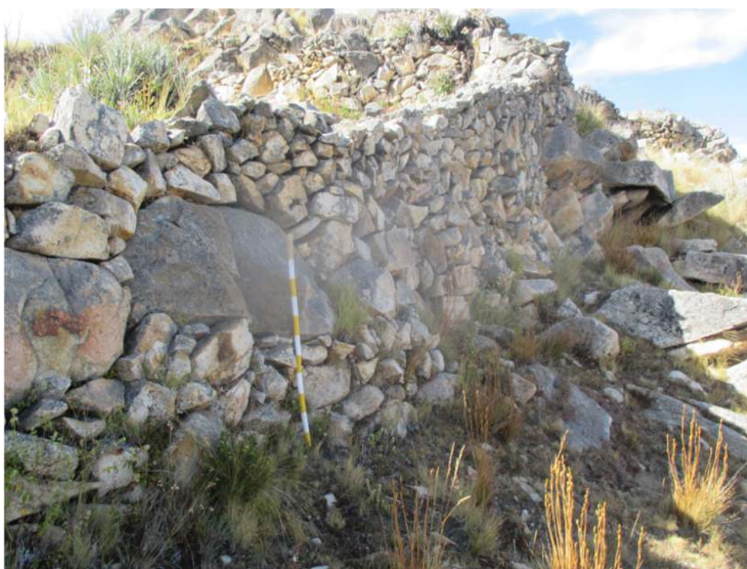
Figura 50. Vista del paramento del muro oeste del subsector 2.
