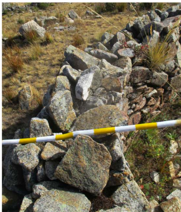
Figura 185. Detalle de relleno del muro, de una estructura habitacional (EHS-187), sector A, subsector 4.
