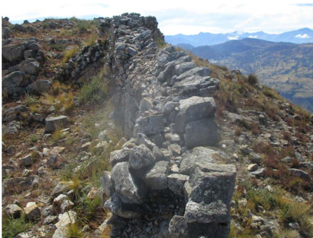
Figura 195. Detalle del relleno del muro de una muralla ubicado en la parte sur (ED-3)
