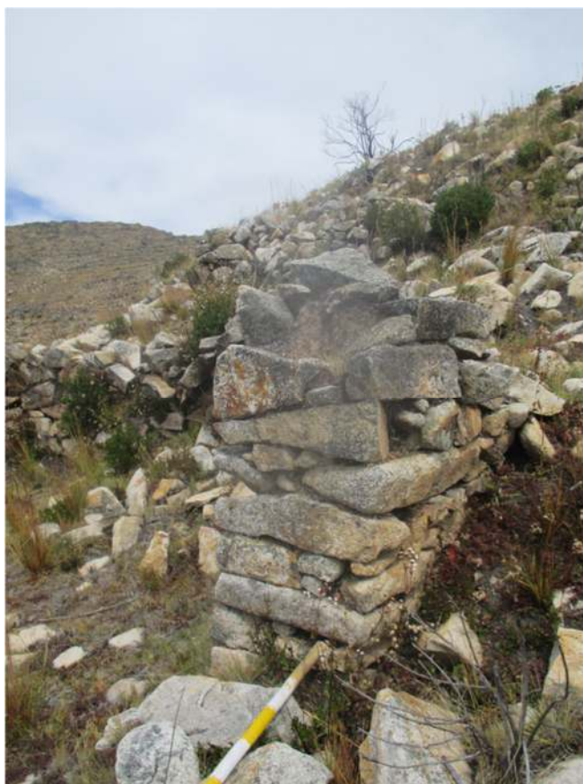
Figura 189. Detalle de frontal del muro de un acceso a una estructura habitacional (EHS-197) sector B
