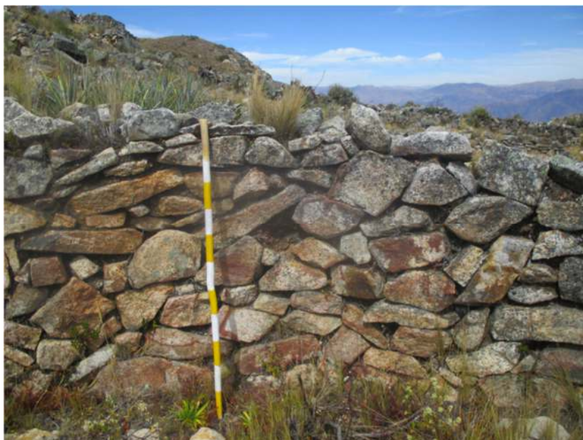
Figura 182. Paramento interno de una estructura habitacional (EHS-68).
