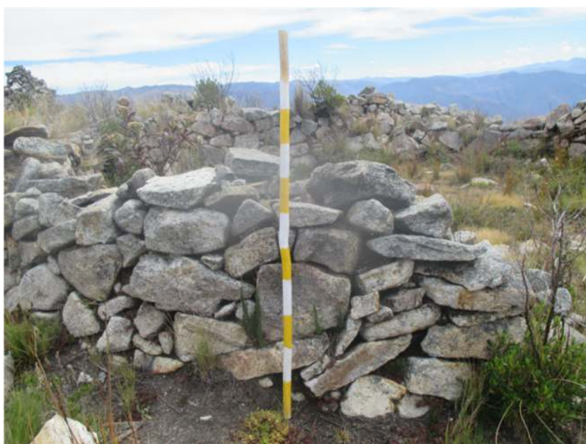
Figura 183. Detalle del paramento externo de una estructura habitacional (EHS-148).
