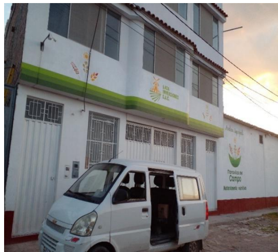
Figura N°16: Estado de mejora de la fachada (pintado, mallas, logotipo, etc.), en la planta de procesamiento LADA INVERSIONES EIRL - 2020
