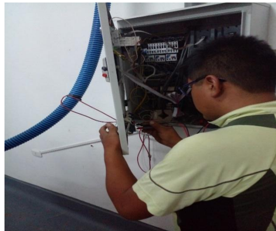
Figura N°04: Mantenimiento correctivo del tablero de control del extrusor. Sr. Yulex – Técnico electricista.
