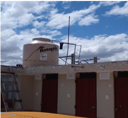
Figura N°05: Estado de la ubicación del tanque principal de agua de la planta de procesamiento LADA INVERSIONES EIRL - 2019
