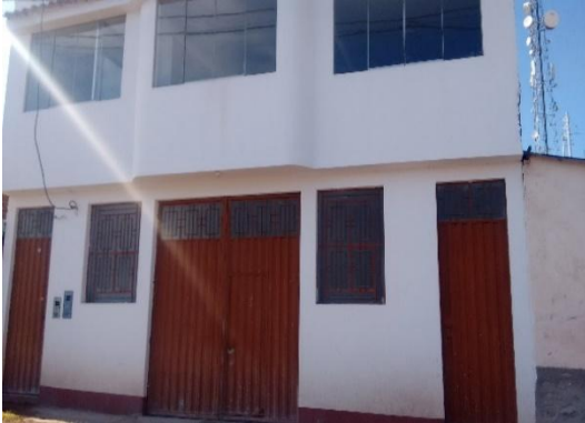
Figura N°01: Estado de fachada de la planta de procesamiento LADA INVERSIONES EIRL. – 2019.
