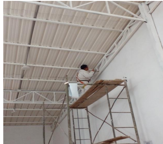
Figura N°06: Trabajos de mejora (pintado), en la planta de procesamiento LADA INVERSIONES EIRL - 2020
