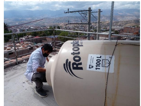
Figura N°06: Mantenimiento preventivo del tanque de agua (Limpieza y desinfección). Personal: Oriol – Bach. Ind. Alim.
