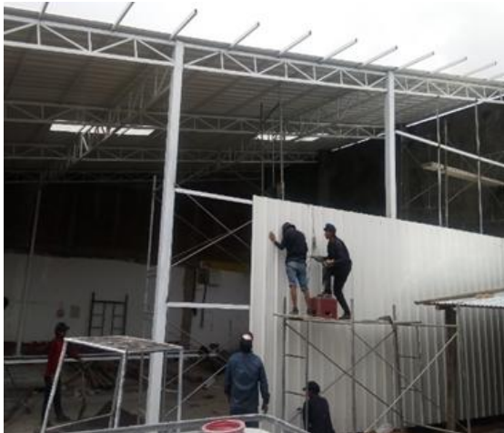
Figura N° 07: Trabajos de construcción del nuevo almacén para el material primario
