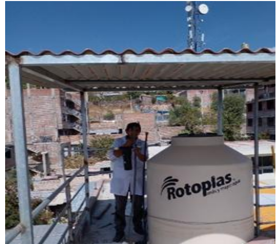
Figura N° 08: Tanque de agua principal protegido por techo
