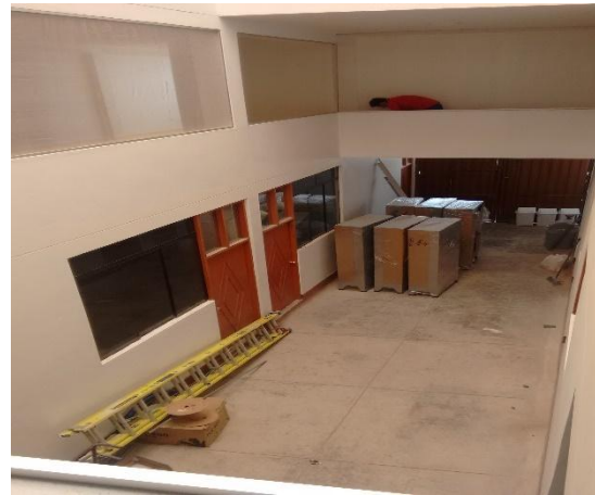
Figura N°04: Estado del interior del primer piso de la planta de procesamiento LADA INVERSIONES EIRL - 2019
