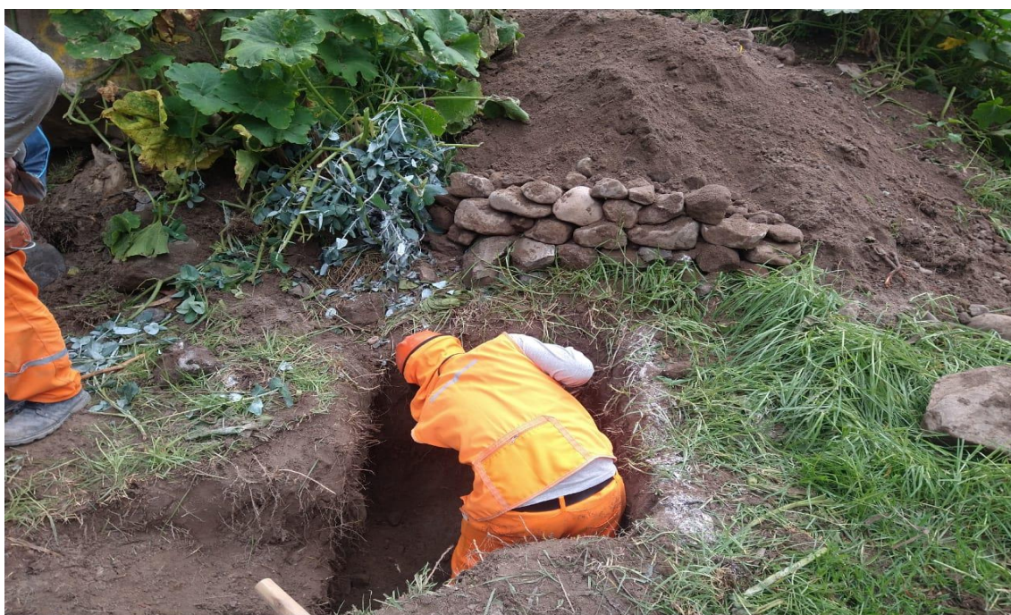
Fotografía 2: Vista de los trabajos de excavación que afecta el suelo y la vegetación existente
