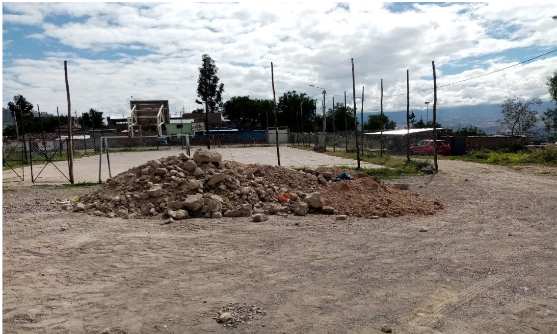
Fotografía 4: Material excedente derivado de los trabajos de excavación
