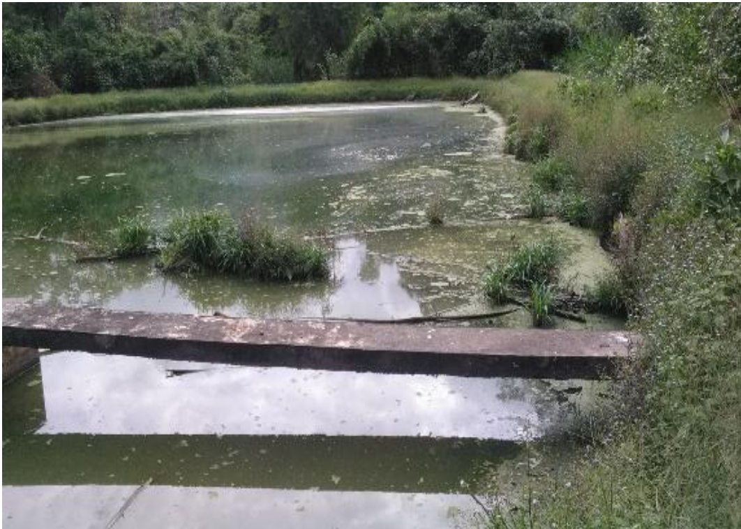
Imagen 5. Vista de natas y crecimiento de plantas acuáticas en laguna de estabilización
