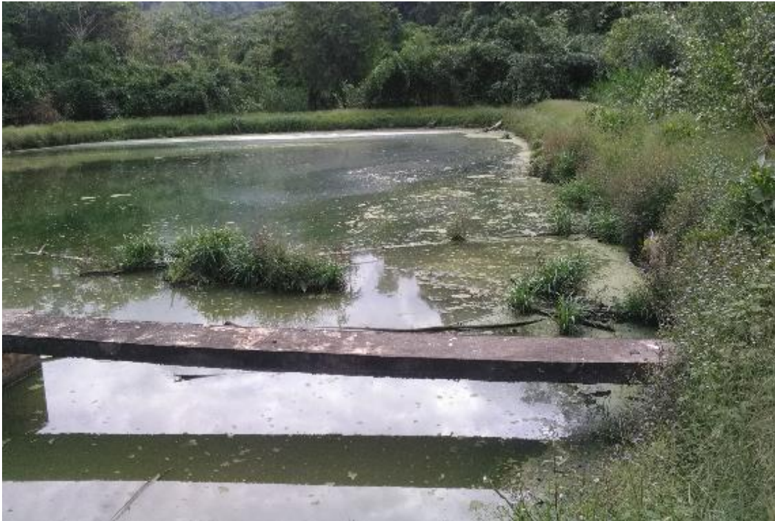
Imagen 5 Vista de natas y crecimiento de plantas acuáticas en laguna de estabilización.
