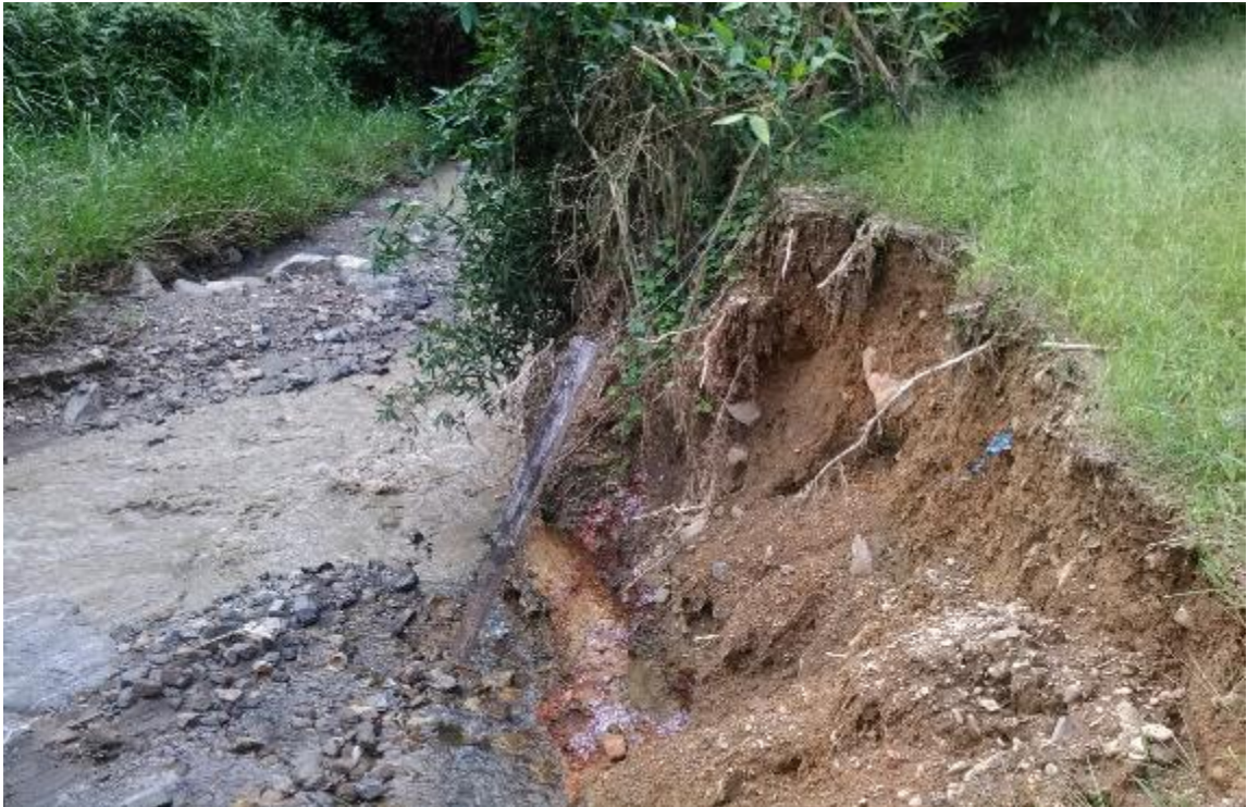
Imagen 7 Filtración del agua residual hacia el riachuelo por la corona socavado
