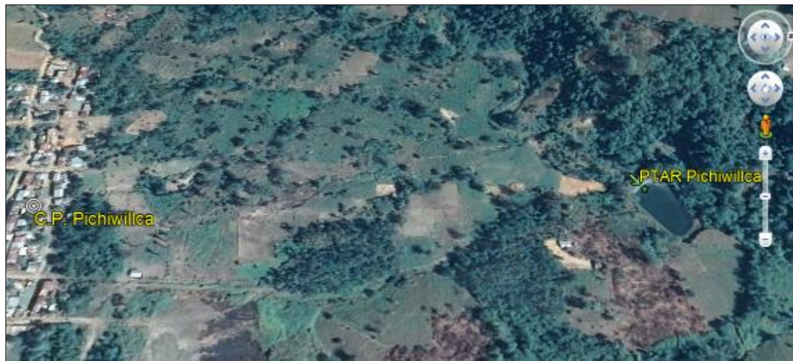
Figura 1.5 Ubicación del PTAR Pichiwillca
