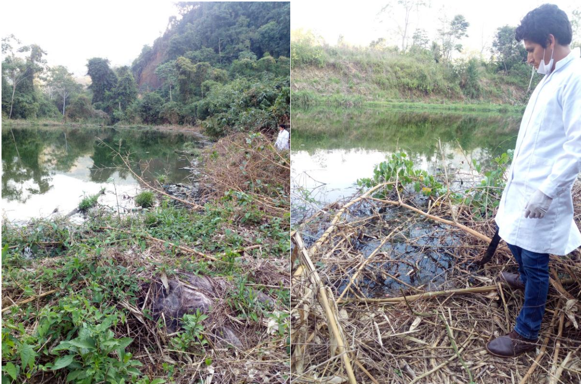
Fotografía 05 Vista de la laguna de estabilización
