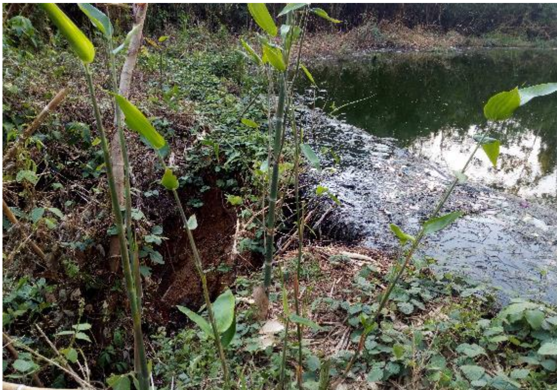
Imagen 6 Rebalse de laguna por la socavación de río, fecha enero del 2020.
