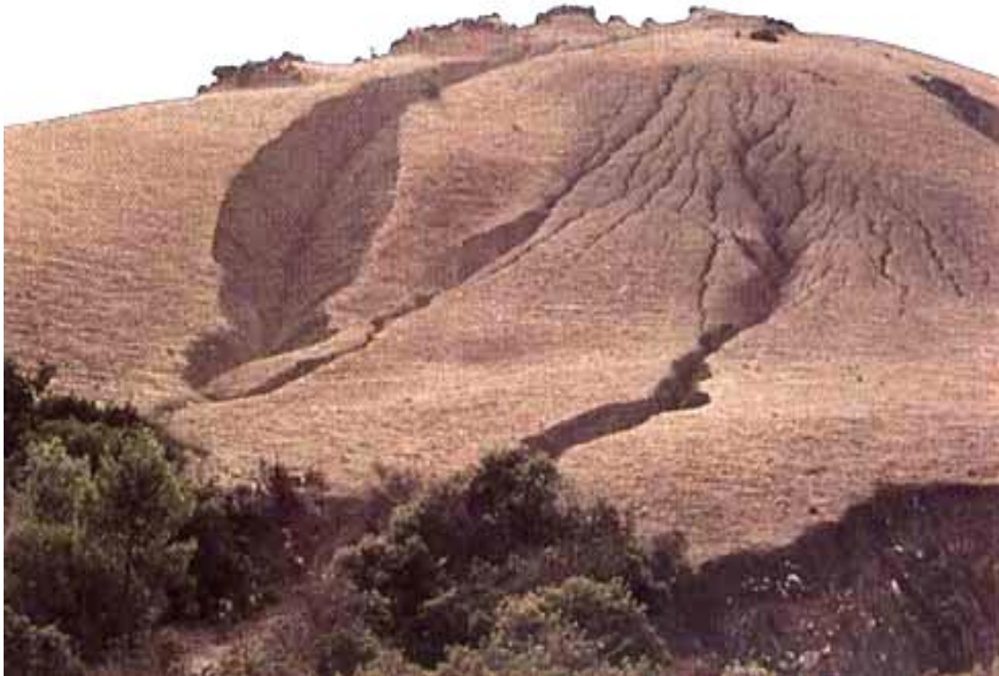
Figura No: 02 Vista de una ladera de la sierra en pleno proceso de erosión con cárcavas y surcos
