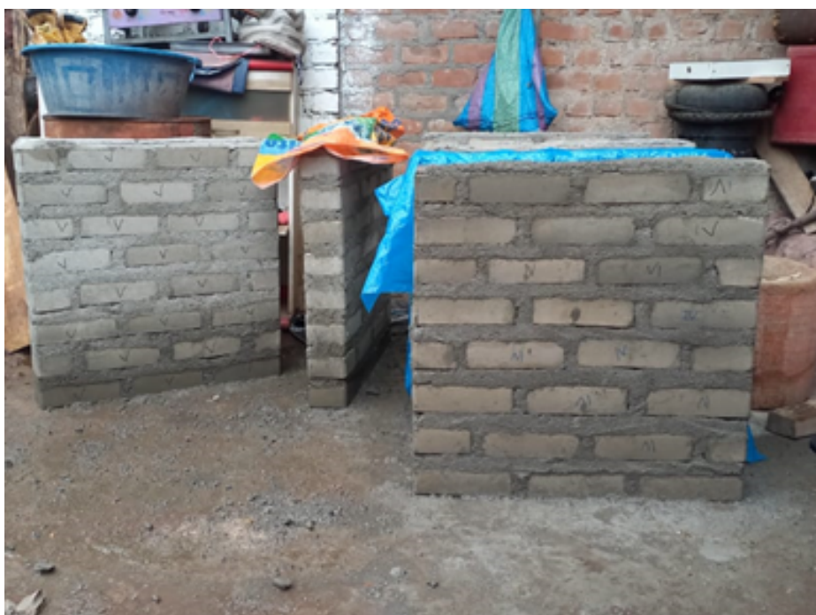
Figura N° 3.17: Elaboración de muretes
