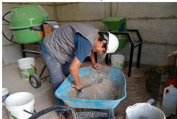
Figura N° 3.5: Mezcla de materiales para el concreto
