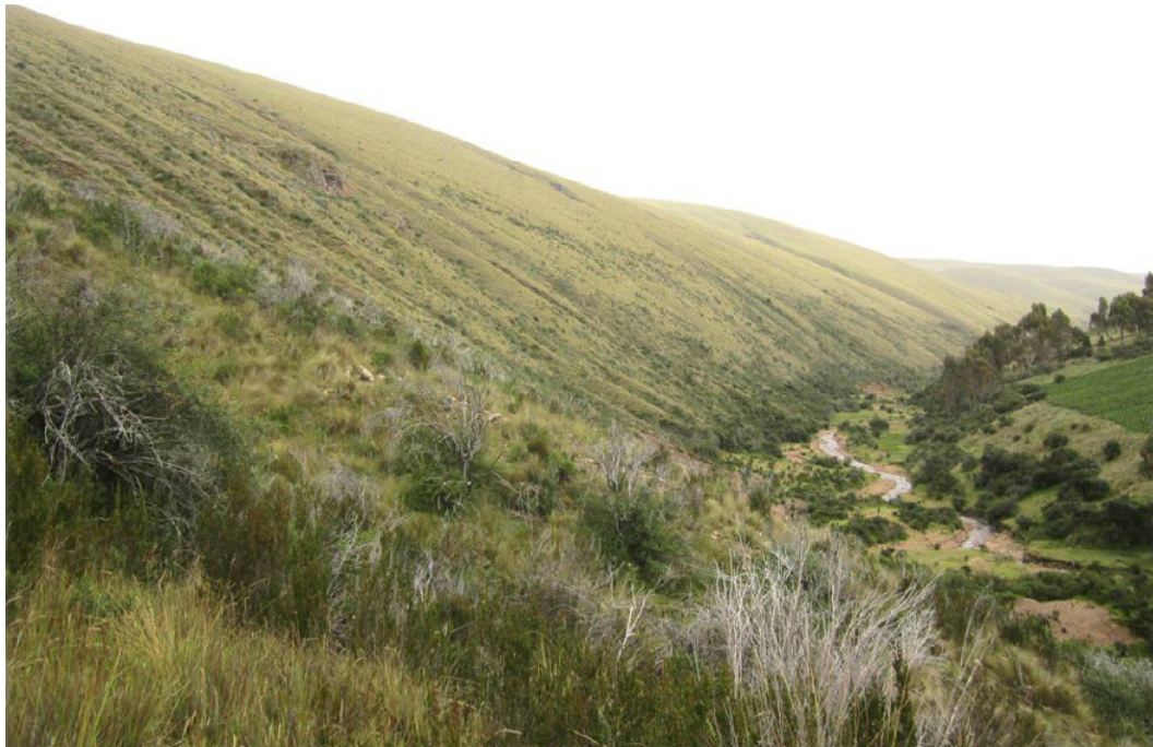
Figura 3.51: Zona del vaso, se observa al fondo los depósitos aluviales y luego suelos residuales a macizos rocosos blandos
