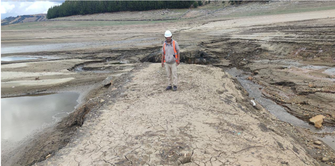
Figura 51 Situación de un de margen de la presa
