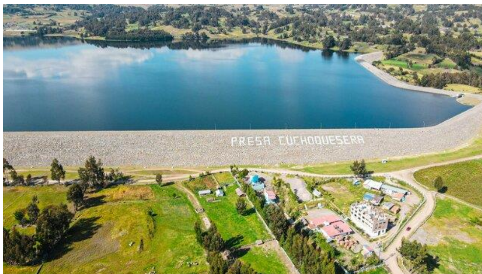
Figura 9 Dique de la presa Cuchoquesera
