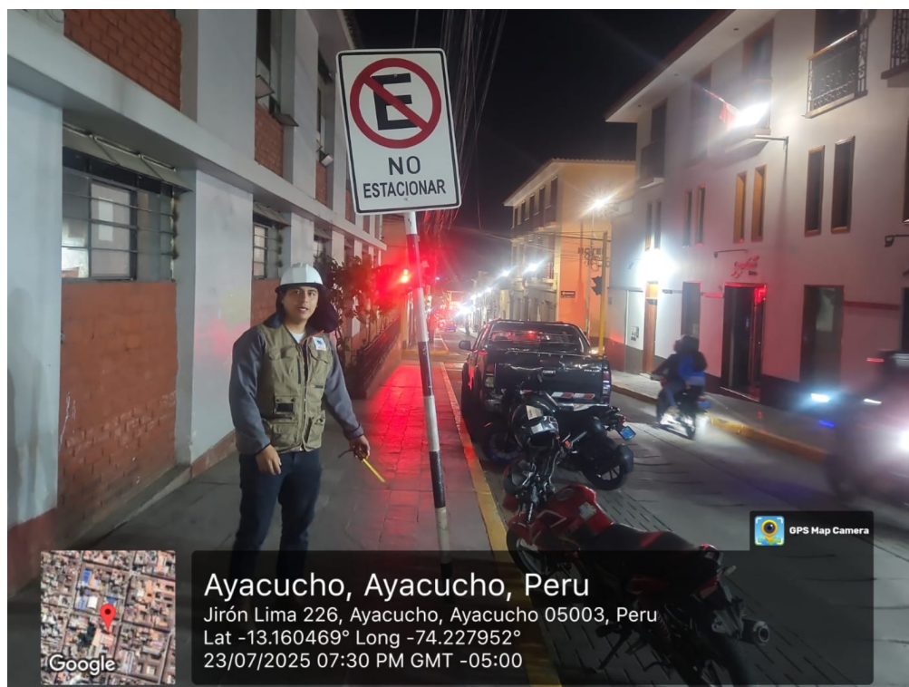
Figura 153: Señal (R-27A) presenta inclinación lateral considerable Fuente: Imagen propia
