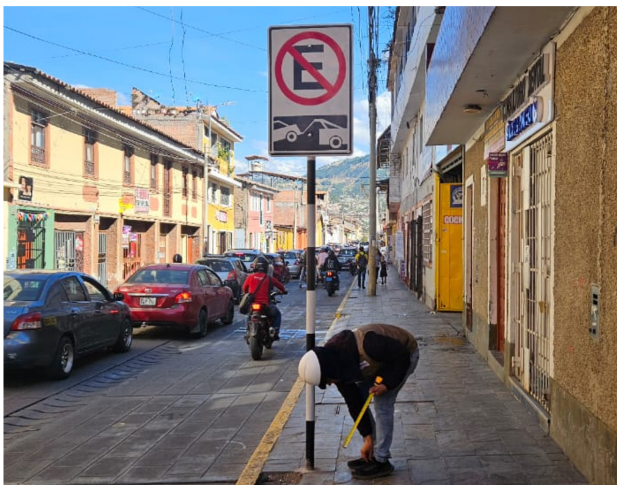
Figura 145: Verificación del estado situacional de la señalización (R-27A) Fuente: Imagen propia
