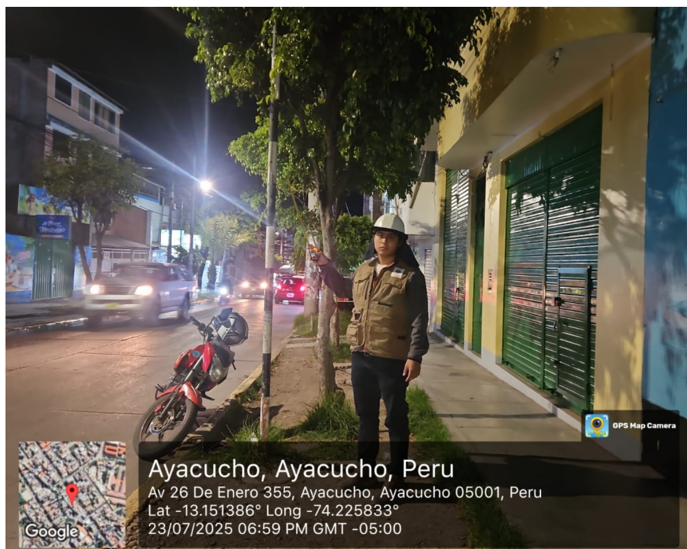
Figura 157: Instalación de las cámaras de investigación Fuente: Imagen propia
