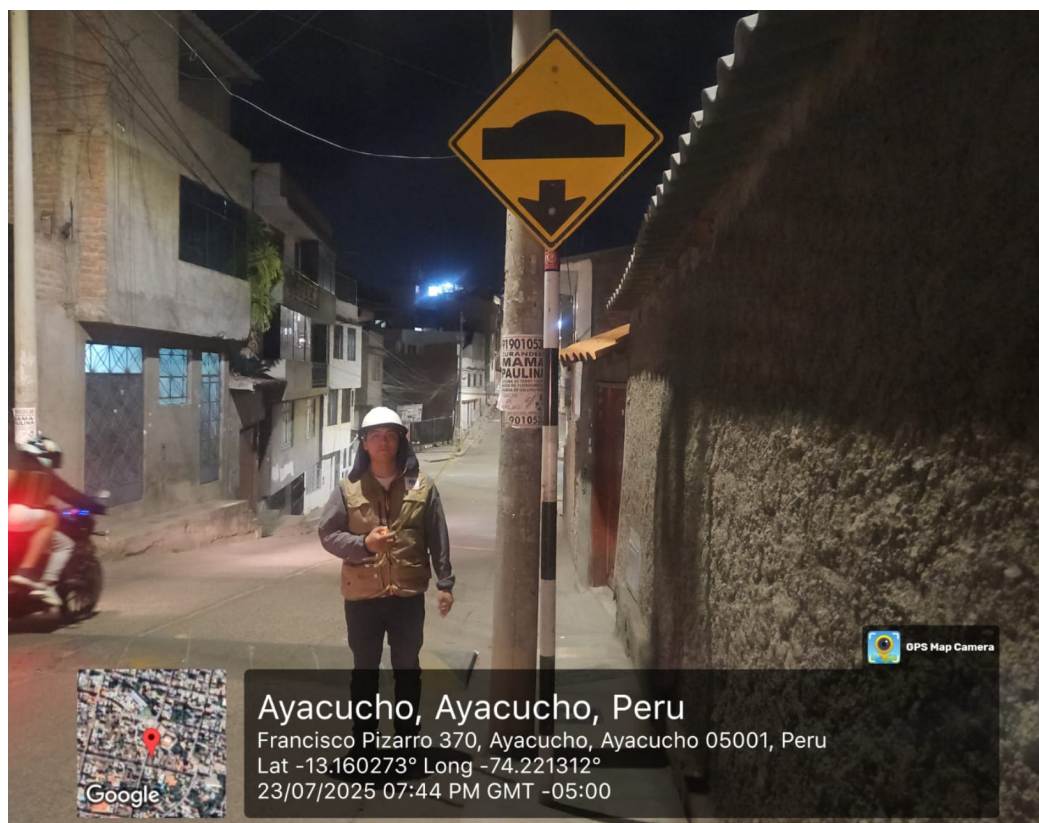
Figura 147: Señal preventiva (P-33A)-Ubicada inadecuadamente Fuente: Imagen propia
