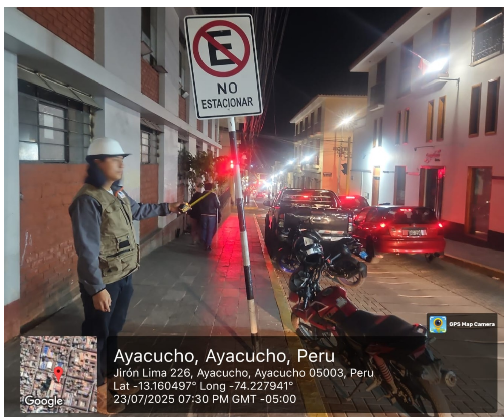
Figura 154: Señal (R-27A) sin parante de soporte estructural independiente Fuente: Imagen propia
