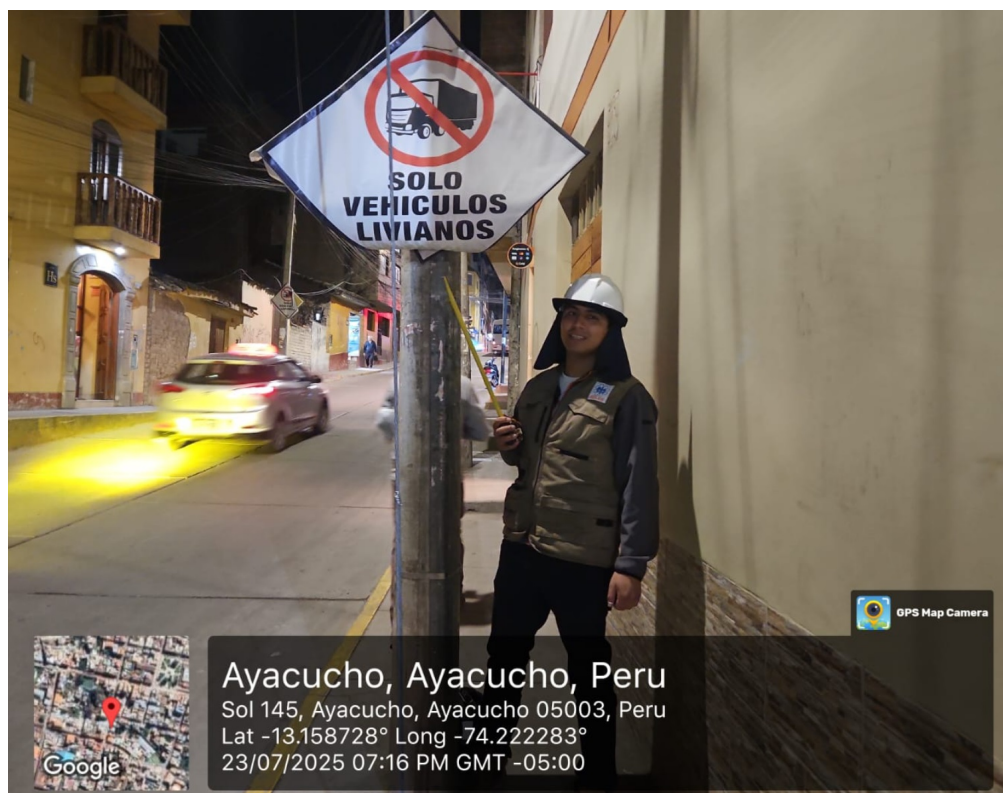
Figura 155: Señal (R-27A) sujeta directamente al poste de alumbrado público Fuente: Imagen propia
