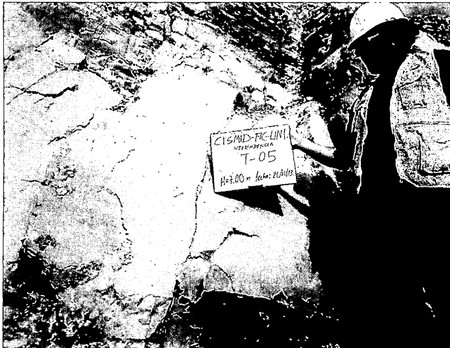
FOTO 54: En el Talud T-5, de 0.00 a 7.00 m se tiene formación rocosa con fracturas.
