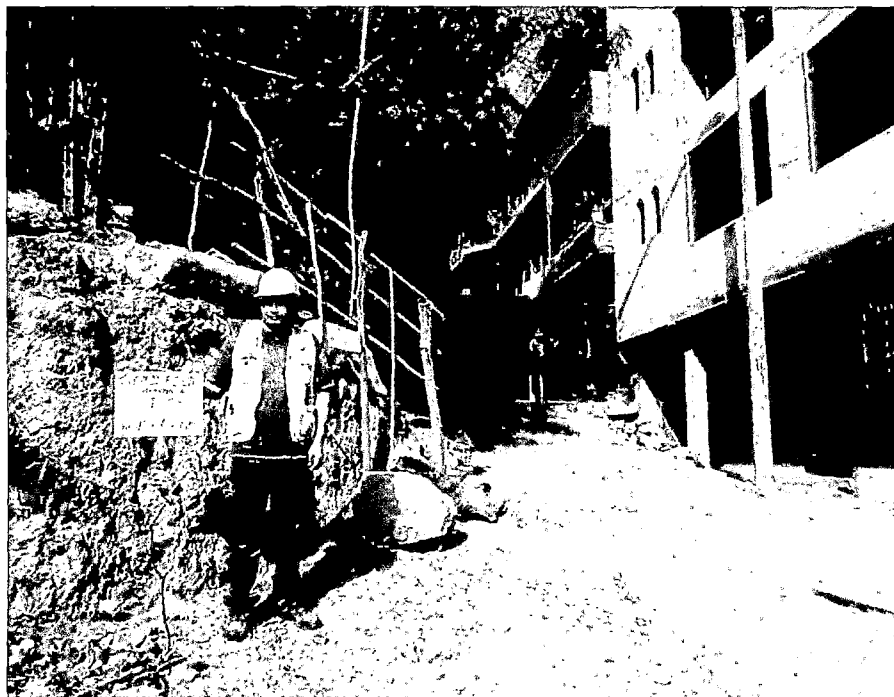
FOTO 51: Talud T-4, Ubicado cerca a la Av. 17 de noviembre. Ver Plano P-07.
