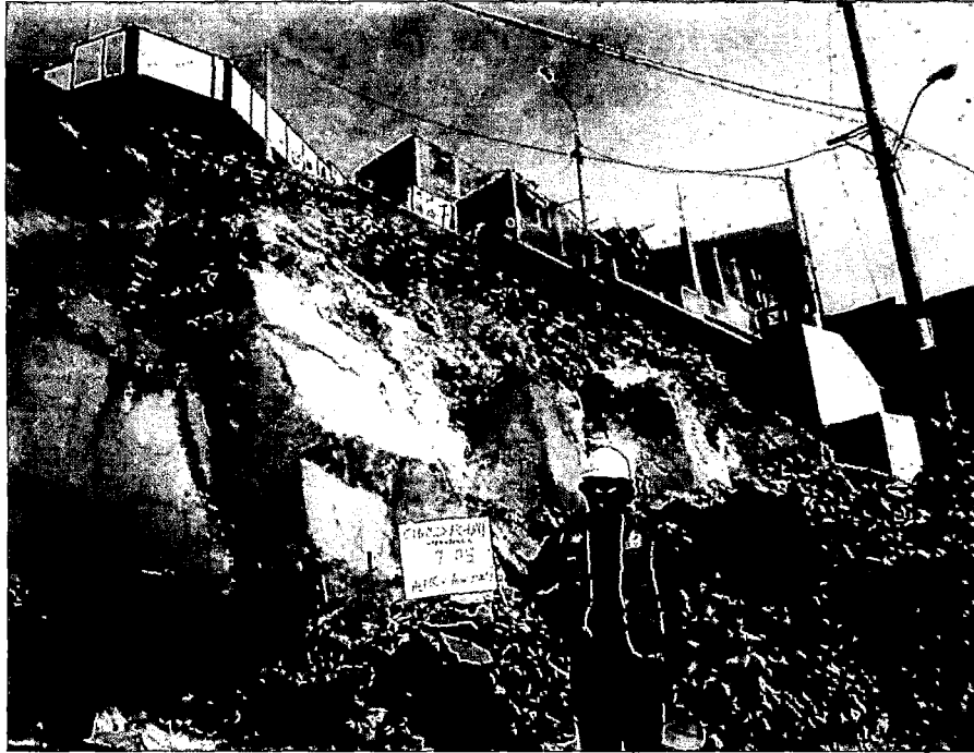
FOTO 53: Talud T-5, Ubicado por inmediaciones de la última cuadra de la calle Collasuyo. Ver Plano P-07.
