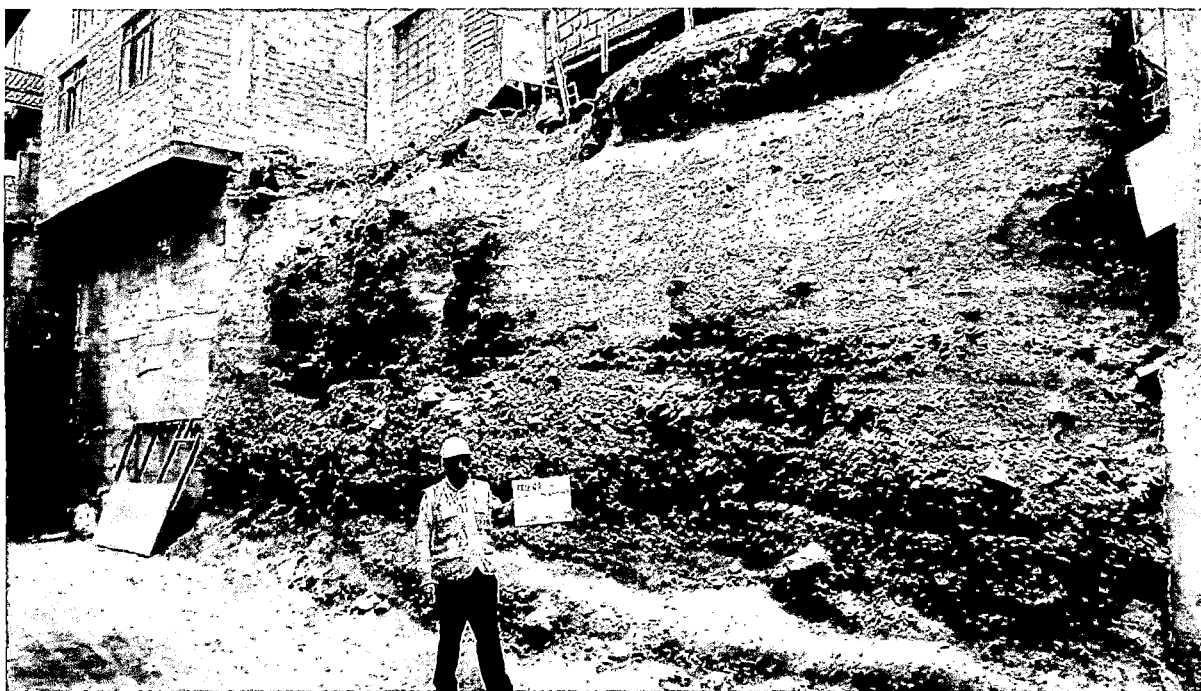
FOTO 57: Talud T-7, Ubicado entre la Av. Chinchaysuyo y la calle Ramiro Priale. Ver Plano P-07.
