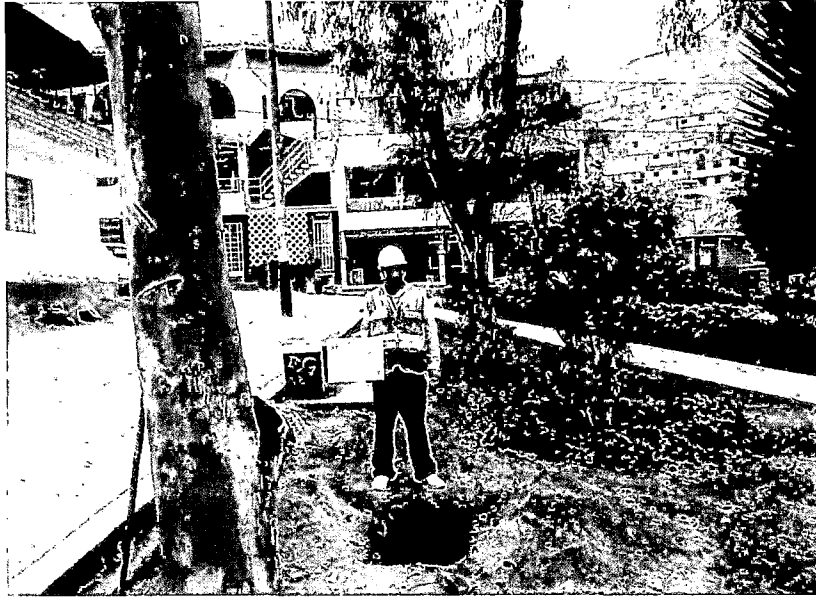
Figura 4.1: Calicata C-17, ubicada en la calle Huarcondor.
