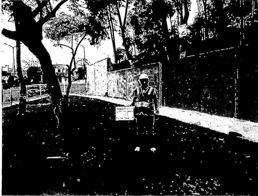
FOTO 31: Calicata C-16, ubicada entre la Av. Indoamerica y la calle Chimú. Ver Plano P-07.
