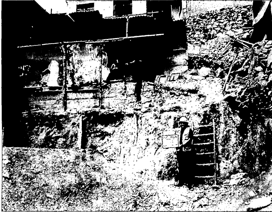
FOTO 45: Talud T-1. Ubicado al final del pasaje Heraud a dos cuadras de la Av. Ollantaytambo. Ver Plano P-07.
