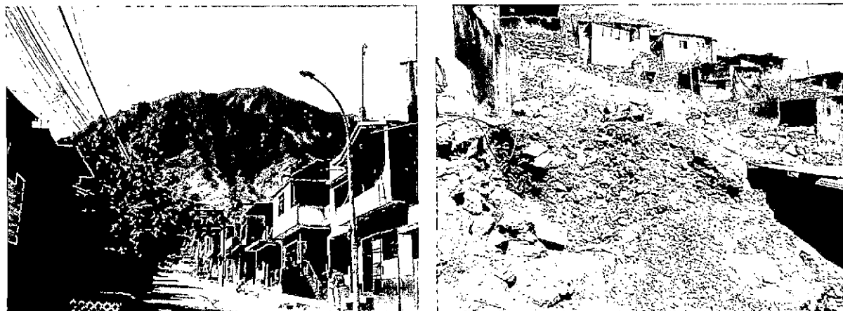
Figura 2.9: Cerros de pendiente abrupta, con caídas de bloques de rocas (a). Viviendas construidas en material de relleno que se encuentran en forma inestable (b).
