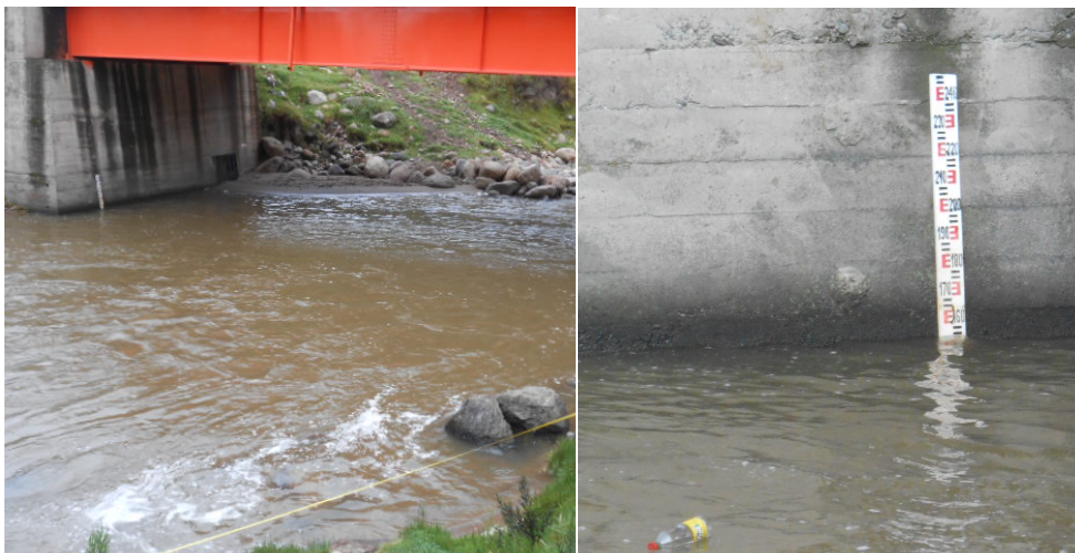
Figura N° 3.22: Estación fluviométrica del puente Casacancha en el río Vinchos (Estación Puente Casacancha).
