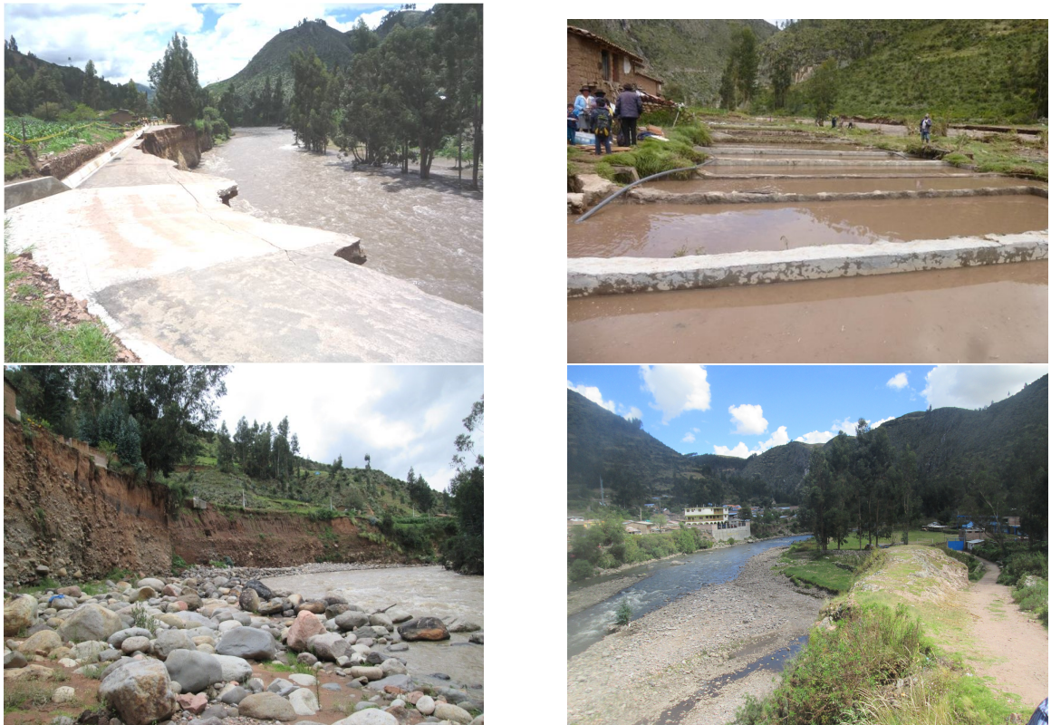
Figura N° 4.7: Algunas inundaciones producidas en la cuenca del rio Vinchos por caudales extraordinarios.
