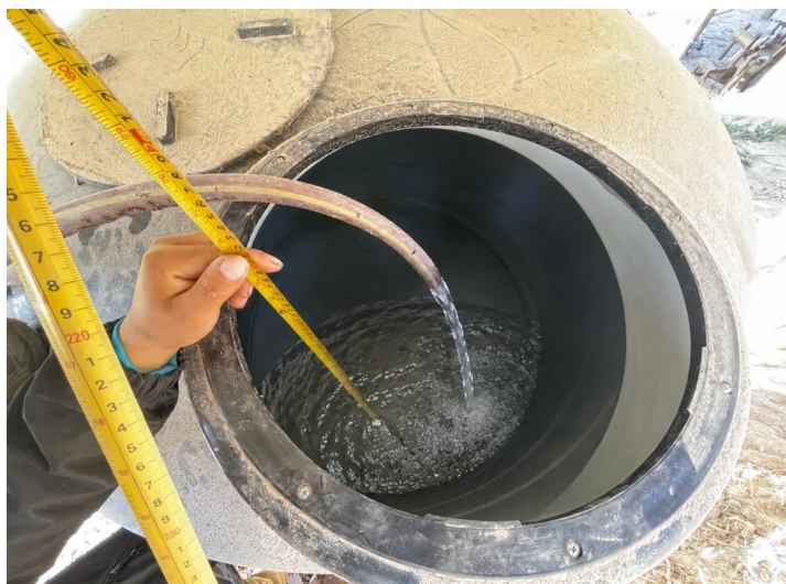
Figura 67 Llenado del tanque con el sistema FV
