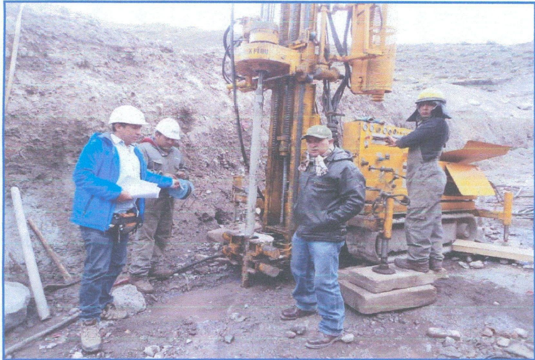
FCTCGRAFIA N° 03: Vista pruebas de permeabilidad (Ensayo de Lefranc).
