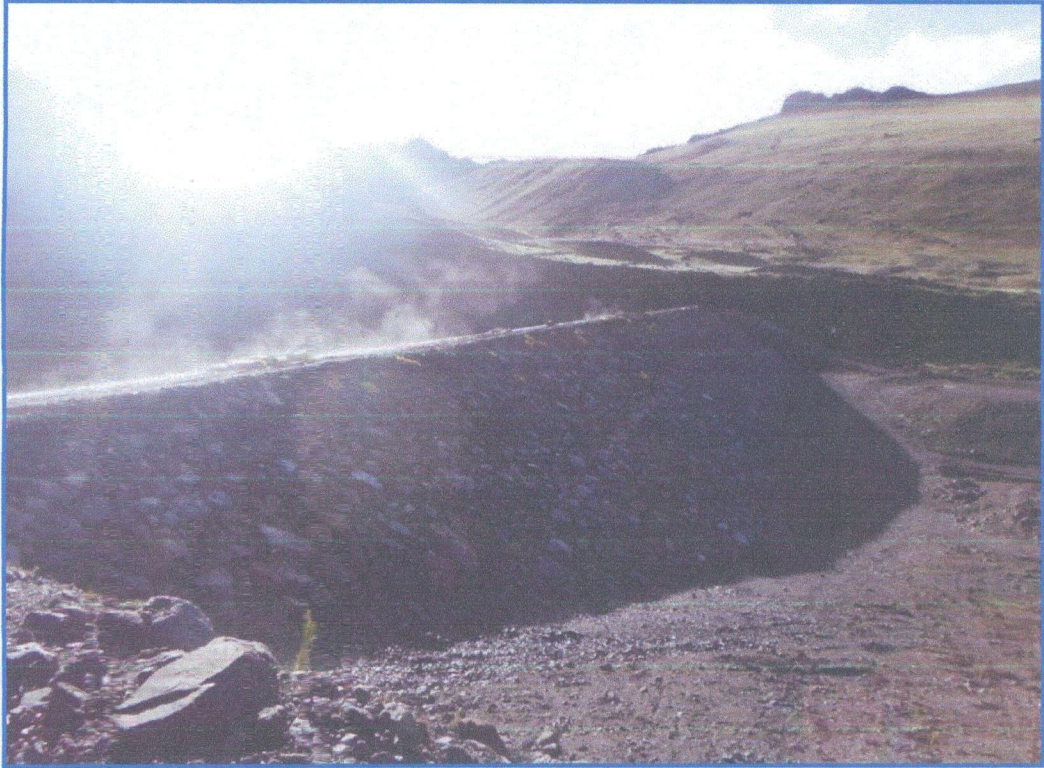
FOTOGRAFIA N° 07: Cuerpo y espaldón concluido de la presa.
