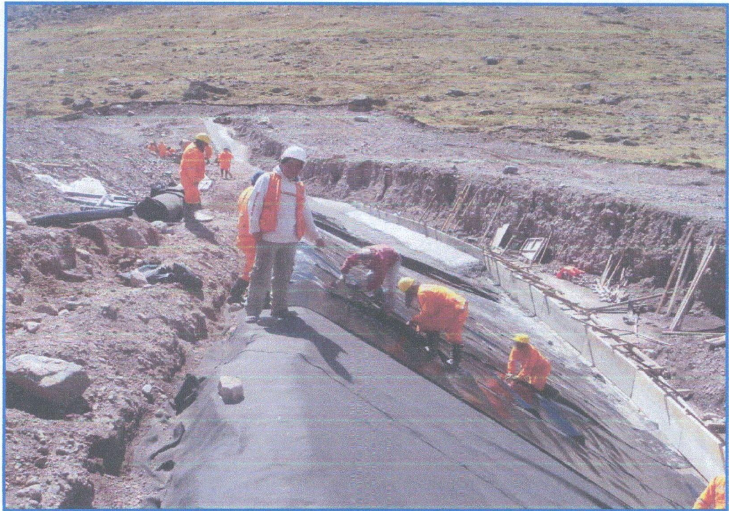
FOTOGRAFIA N° 05: Instalación de geotextil y geomembrana (PVC e=2mm) en zanja de dentellón.
