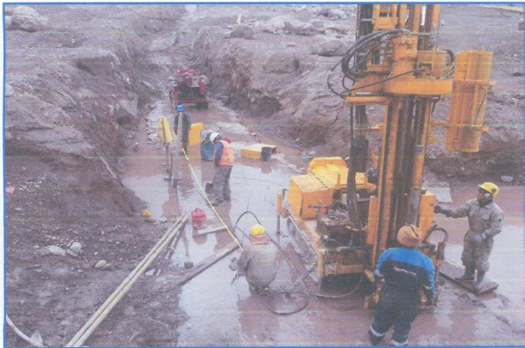
FOTOGRAFIA N° 02: Se puede observar la ubicación de los pozos para la perforación e inyección de concreto
