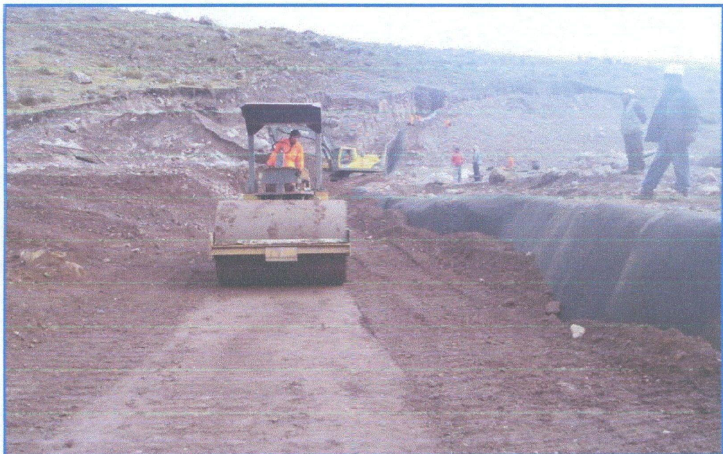
FOTOGRAFIA N° 06: Compactación del material arcilloso zanja de dentellón
