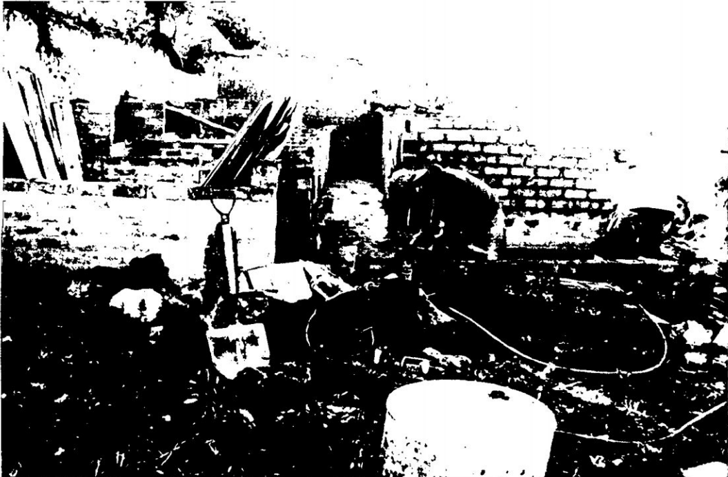
Foto 4: Construcción del alojamiento de los porcinos
