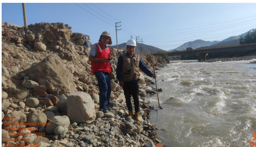
Fotografía 11. Formación de islotes y distribución irregular del cauce en el río Chancay – Huaral
