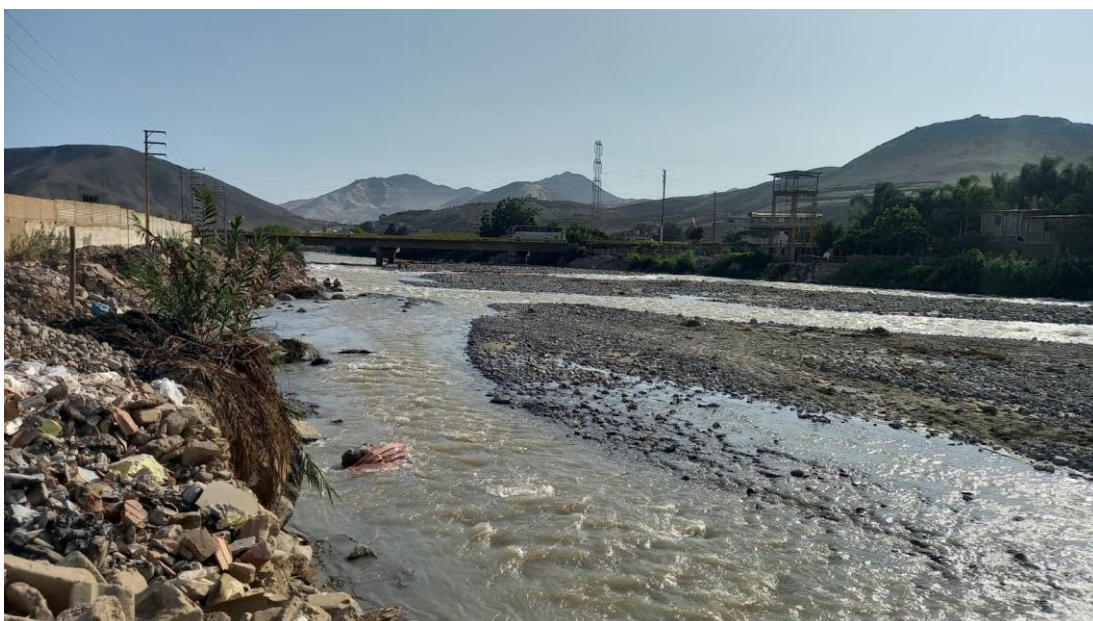
Fotografía 2. Evidencia de desborde e impacto ambiental en el río Chancay – Huaral
