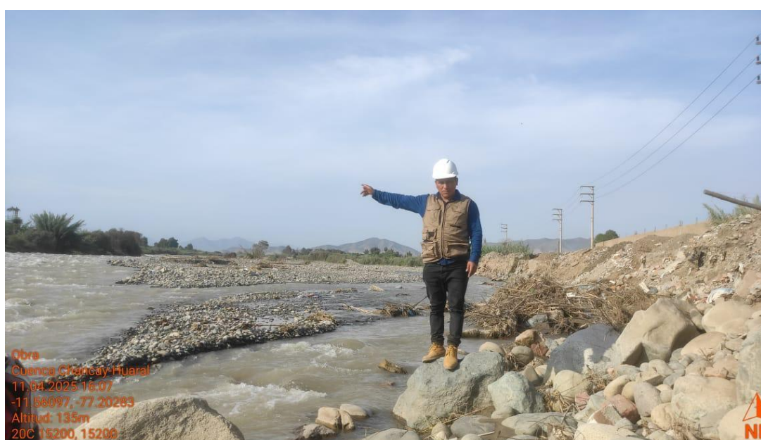
Fotografía 10. Identificación de zona erosionada en margen del río Chancay – Huaral
