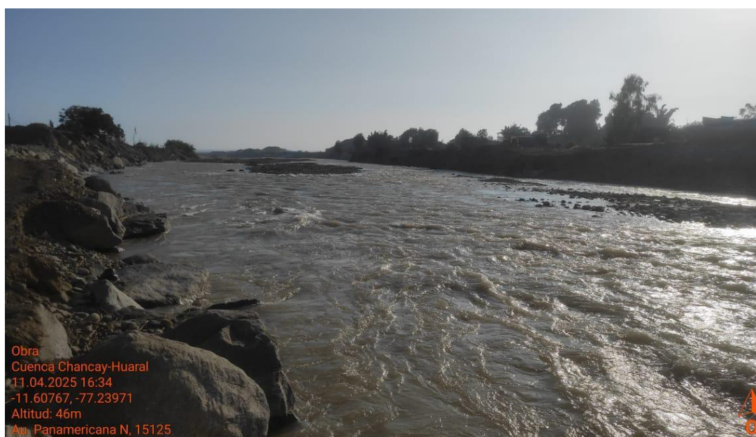
Fotografía 8. Tramo del río Chancay con alta energía de flujo y márgenes inestables – Huaral
