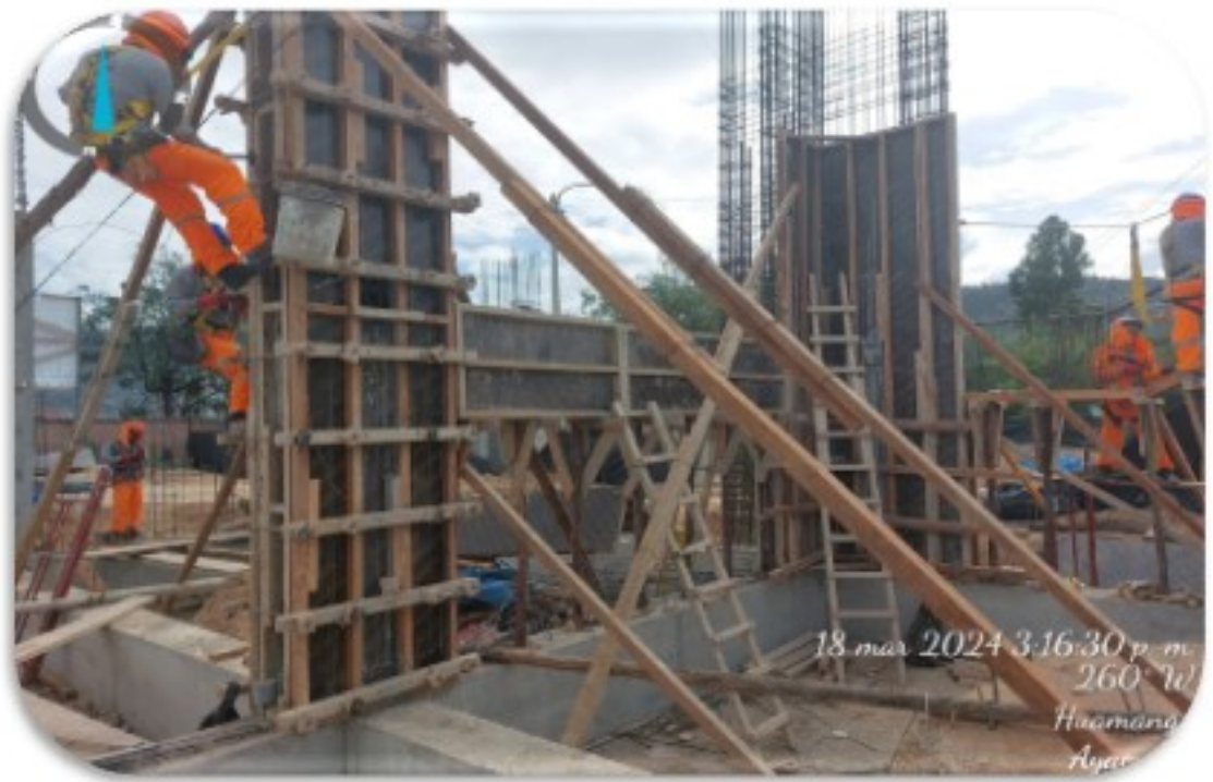
Figura 57. Encofrado y Desencofrado de Placas Modulo A- Simulando el proceso Constructivo en el modulo B.
