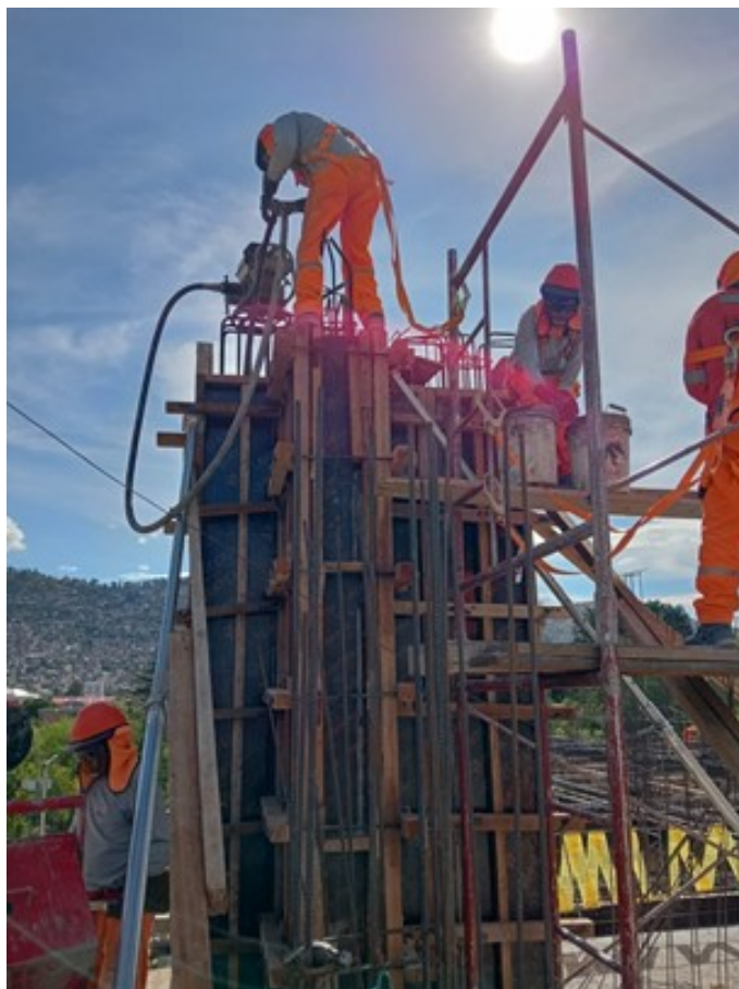
Figura 71. Trabajadores En el grupo B en vibrado de una columna de concreto.
