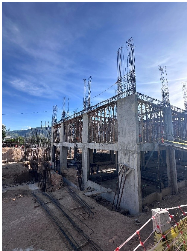
Figura 54. Casco 2do piso Modulo B.
