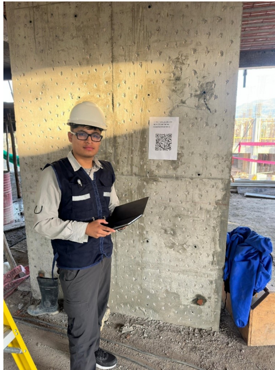
Figura 64. Colocación de códigos Qr del plano de estructuras en Revit para la realidad virtual insitu en el Bloque B del proyecto Medicina Humana-UNSCH.
