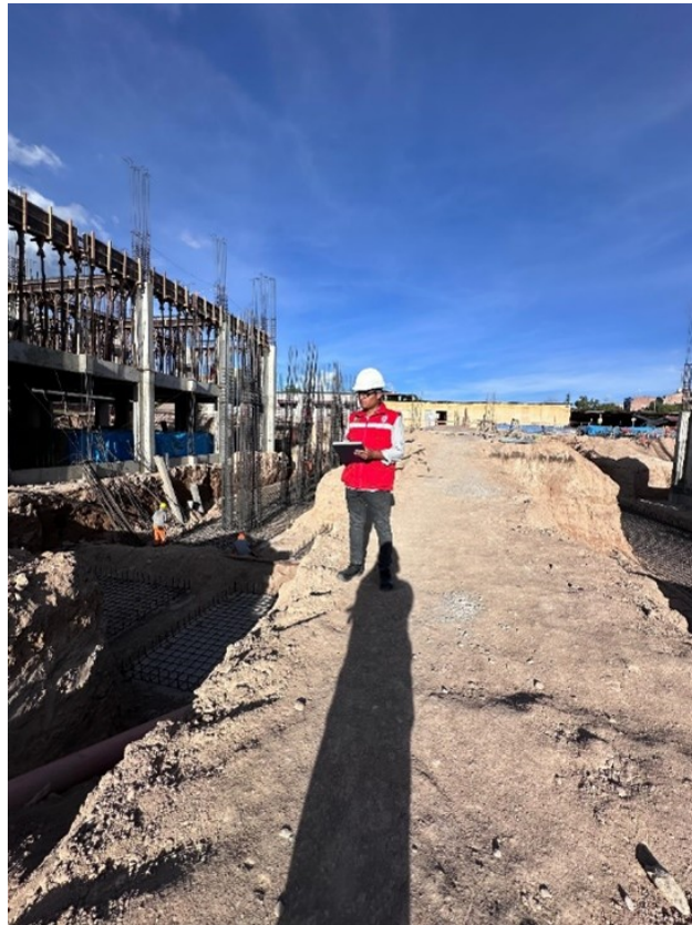
Figura 55. Evaluación de la implementación de LPS. Partida de obras de concreto Armado vigas Acero corrugado f_y=4200 \text{ kg/cm}^2 grado 60 en vigas.
