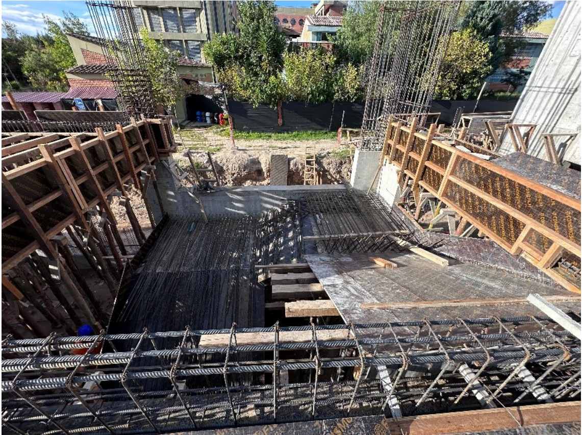
Figura 56. Colocado de acero Corrugado f'y=4200\text{kg/cm}^2 grado 60 en escaleras-Modulo B.
