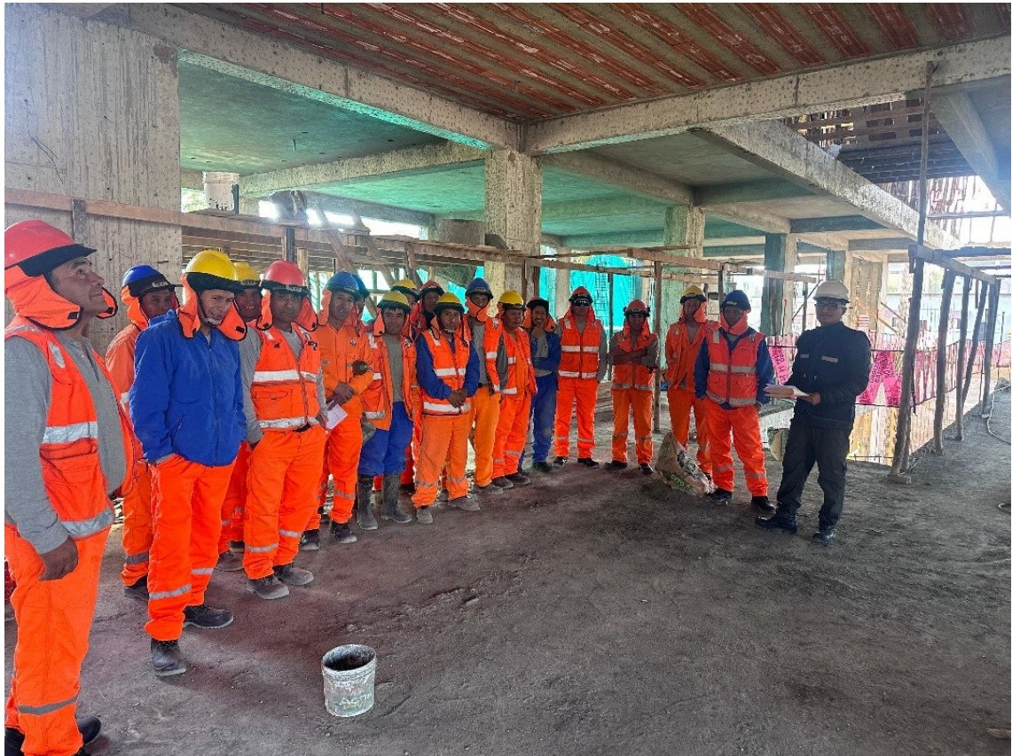
Figura 63. Capacitación en Last Planner System al personal obrero del bloque B de la obra Medicina Humana-UNSCH.
