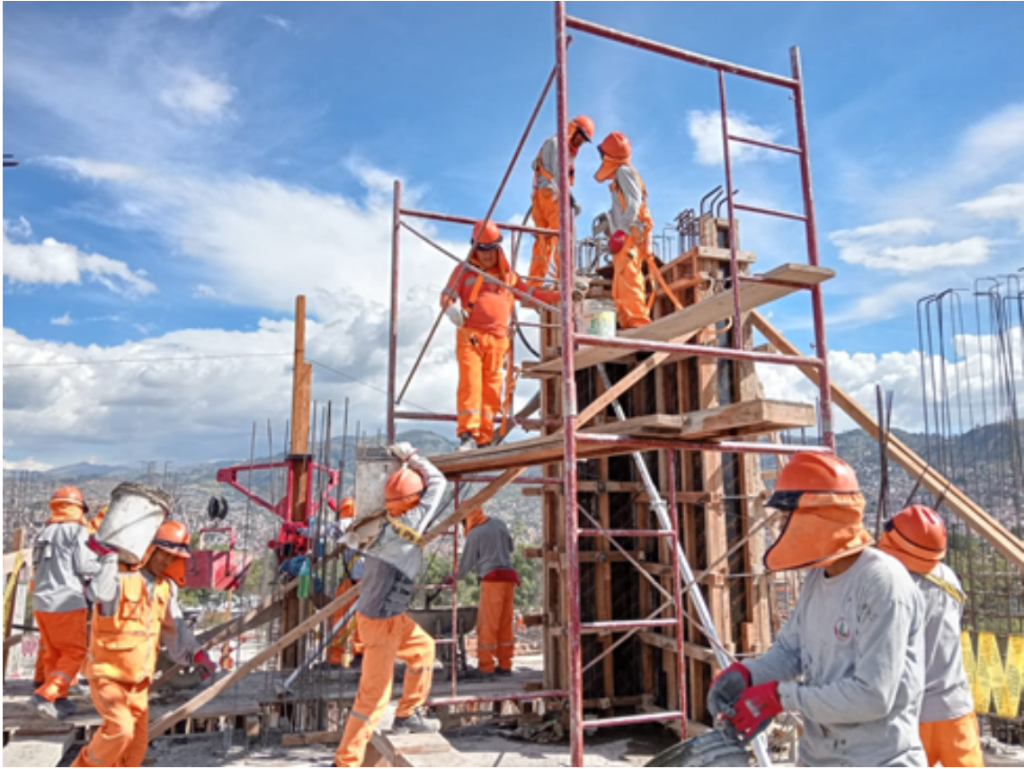
Figura 3. Colaboradores trabajan en el modulo B.
