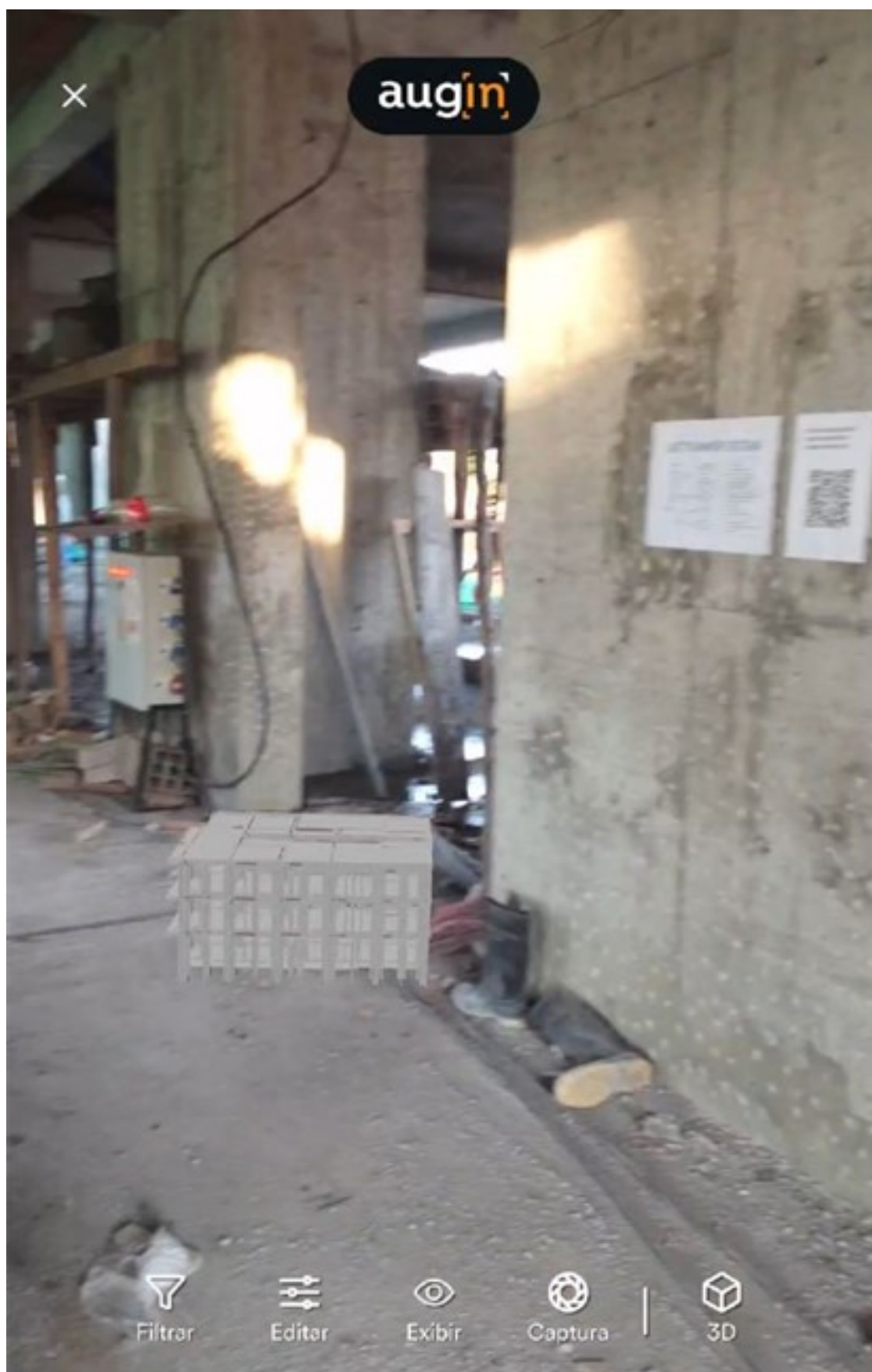
Figura 79. Se empezó con el módulo B de estructuras.
