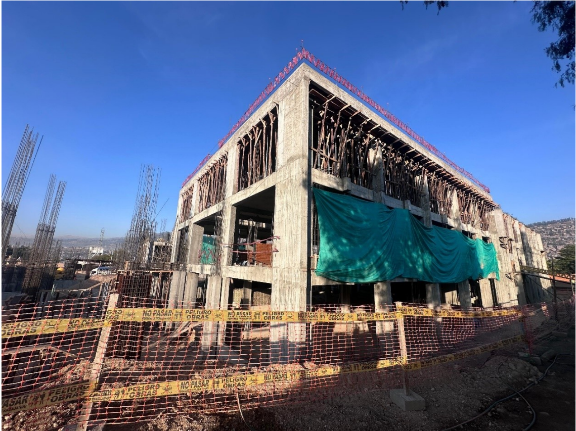
Figura 68. Bloque B terminado parte estructural
