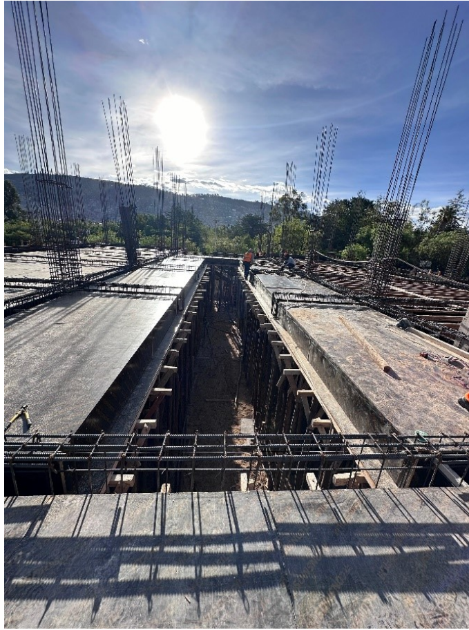
Figura 58. Vista de losa aligerada
