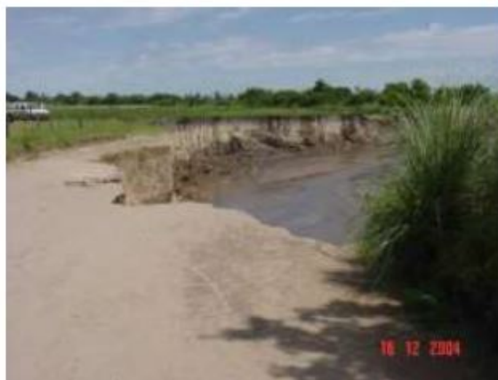
Meandro con erosión activa, arroyo Mosuc Mayu (Córdoba).
