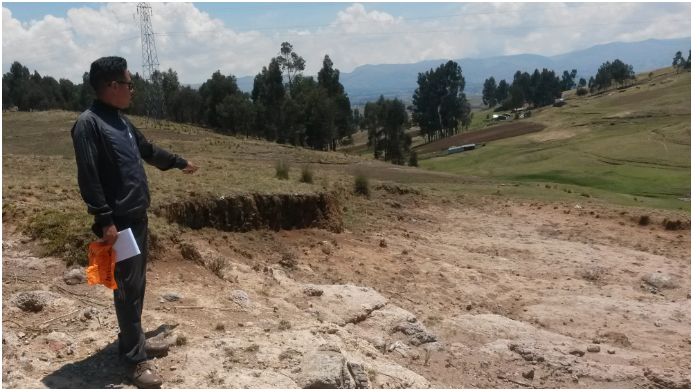
Figura B.1: Suelo completamente erosionado - centro poblado de Pampa Cangallo
