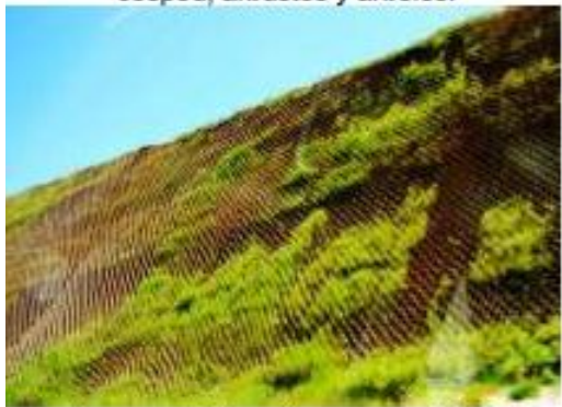
Terraplén en estabilización con recubrimiento de tejidos, tierra con vegetación
