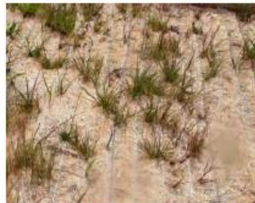
Estabilización de taludes con geotextiles que llevan incluidos tierra y semillas de vegetación herbácea, (El Chaltén, Santa Cruz, SECYOT-UNRC)
