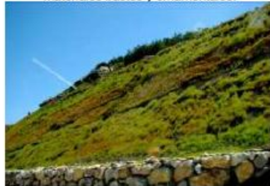
Terraplén ya estabilizado
