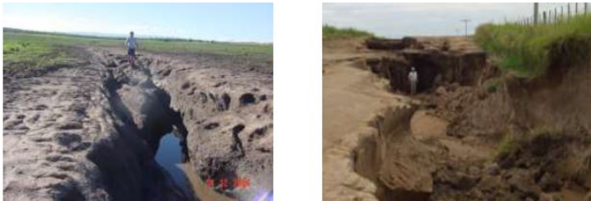
Figura 2.16: Manifestaciones de erosión en cárcavas.
