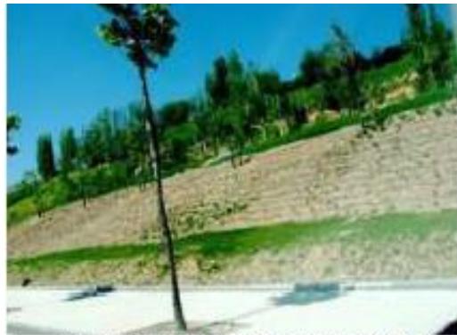
Terraplén estabilizado con geotextil con césped, arbustos y árboles.
