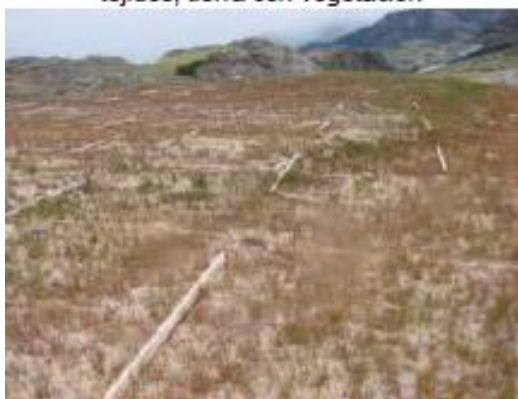
Estabilización de taludes con geotextiles que llevan incluidos tierra y semillas de vegetación herbácea, (El Chaltén, Santa Cruz, SECYOT-UNRC)
