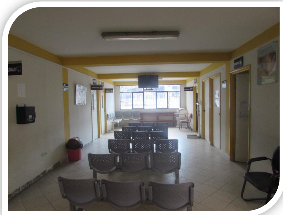
Fotografía 10. Nótese la tipología aporticada con muros de fibrocemento en el interior del pabellón de Consultorios Externos del Hospital Regional de Ayacucho – 2do. Nivel.
