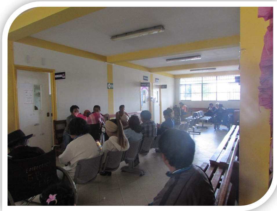
Fotografía 11. Nótese la tipología aporticada con muros de fibrocemento en el interior del pabellón de Consultorios Externos del Hospital Regional de Ayacucho - 1er. Nivel.
