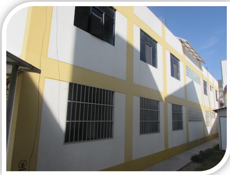
Fotografía 12. Vista posterior del pabellón de Consultorios Externos del Hospital Regional de Ayacucho. Observe el exterior con muros de albañilería confinada.
