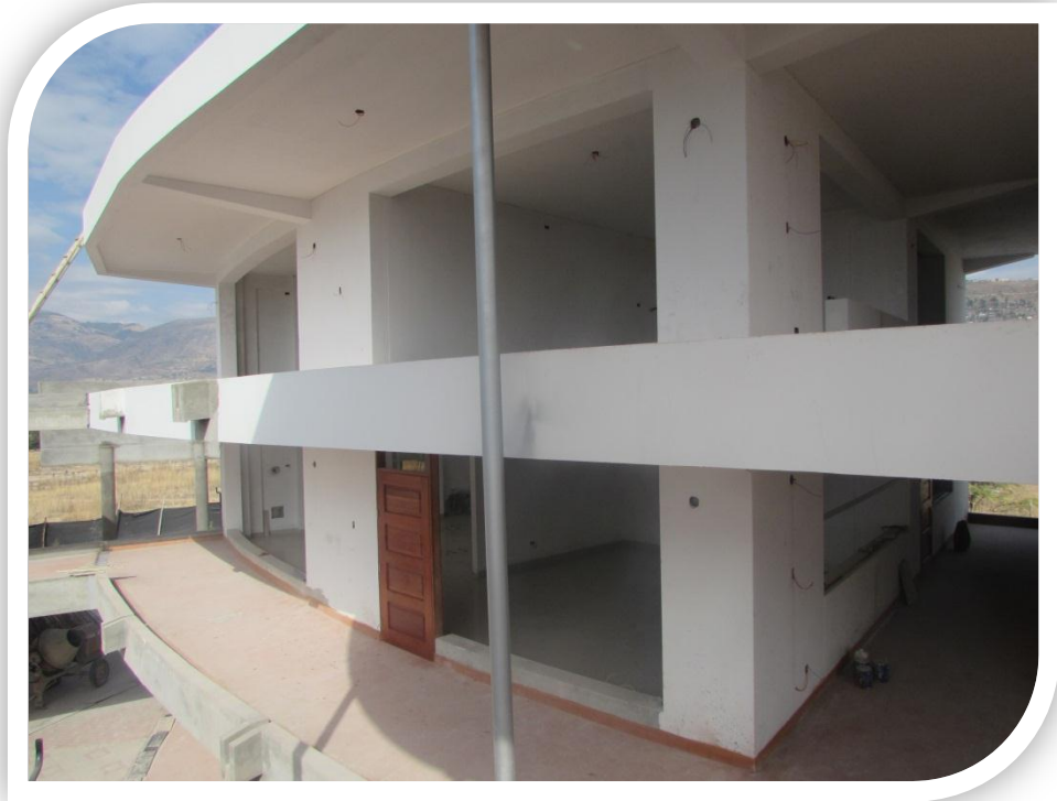
Fotografía 03. Nótese la tipología de construcción de las Oficinas Administrativas de la EFPIC, tipo aporticado con muros de albañilería confinada.
